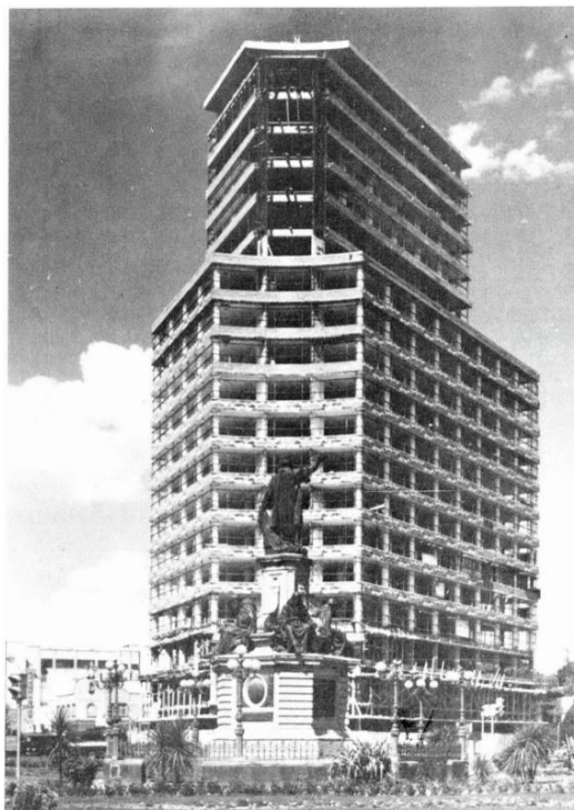
Edificio de Recursos Hidráulicos de los arquitectos Mario Pani y Enrique del Moral, 1952. En esta foto se ve el edificio con las platabandas de mosaicos de metal esmaltado en proceso de colocación, poco tiempo después fueron retiradas. Imagen tomada de: Louise Noelle, "La obra mural de Carlos Mérida. Relación de un desastre", en Anales del Instituto de Investigaciones Estéticas , No. 58, (1987).
