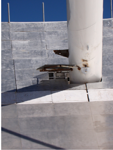
Figura 1.6. Otra vista del Gran Telescopio Milimétrico, se aprecia la superficie formada por las secciones parabólicas fuera de eje. (Foto, cortesía Dr. Rufino Díaz)
