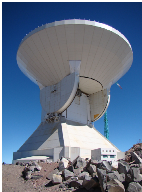
Figura 1.5. Gran Telescopio Milimétrico, ejemplo de óptica segmentada con secciones parabólicas fuera de eje. (Foto, cortesía Dr. Rufino Díaz)
