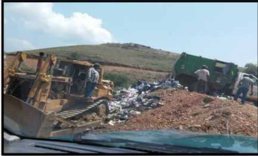
Figura 7.6 Operación en el vertedero municipal.
