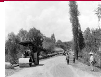
DGPU-08.764448 Zona Geográfica: Acueducto (tramo de Acuexcomatl a Nativitas)
