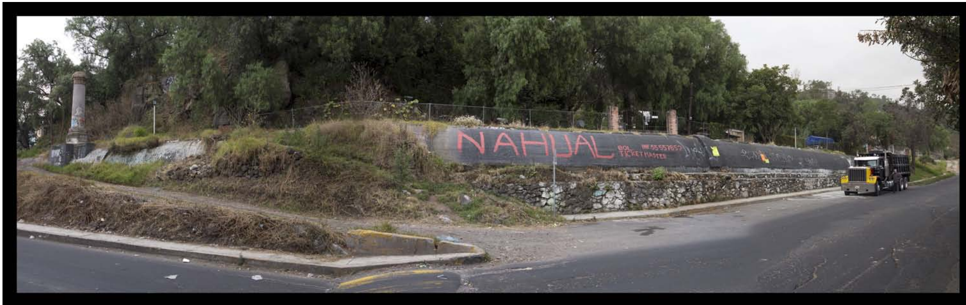
Imagen 31. Lourdes Alonso. Acueducto; tramo carretera Xochimilco-Tulyehualco, Septiembre 2014
