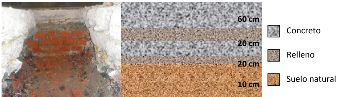
Figura 3.1. Capas del concreto armado hasta el suelo natural y esquema de las capas con sus respectivos espesores.
