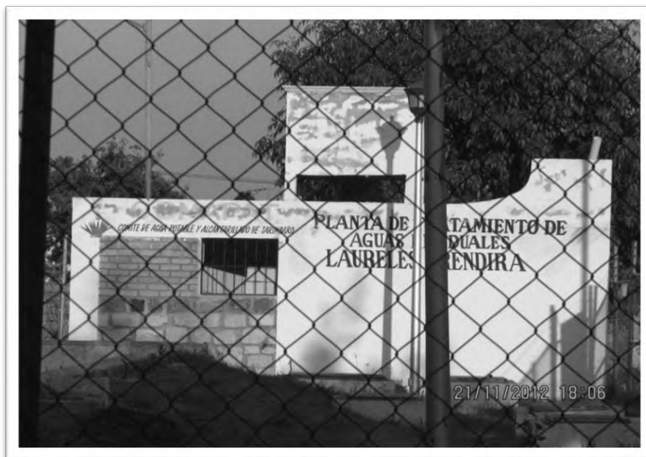
Figura 39. Planta tratadora en fraccionamiento de Tarímbaro, fuera de servicio.
