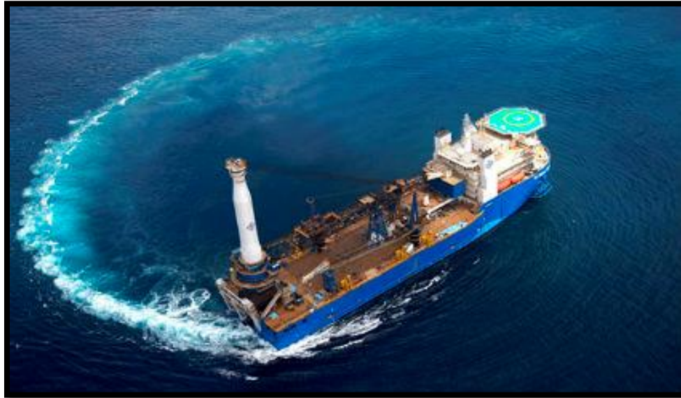
Figura 1.12.- FPSO con posicionamiento dinámico. Moho-Bilondo FPU ubicado en República del Congo
