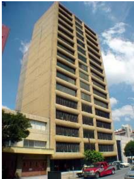
Fig. 1.27. Edificio de 16 niveles.
