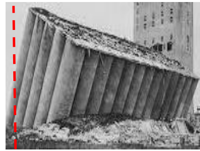
e) Los silos de Transcona, Canadá.
