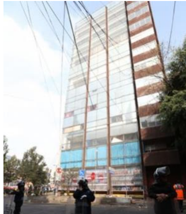
Fig. 1.25. Edificio Chapultepec 480, Roma Norte.
