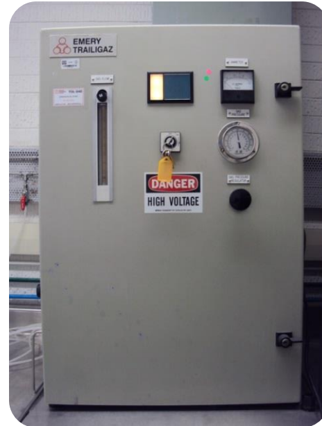
Figura 26 Generador de ozono.
