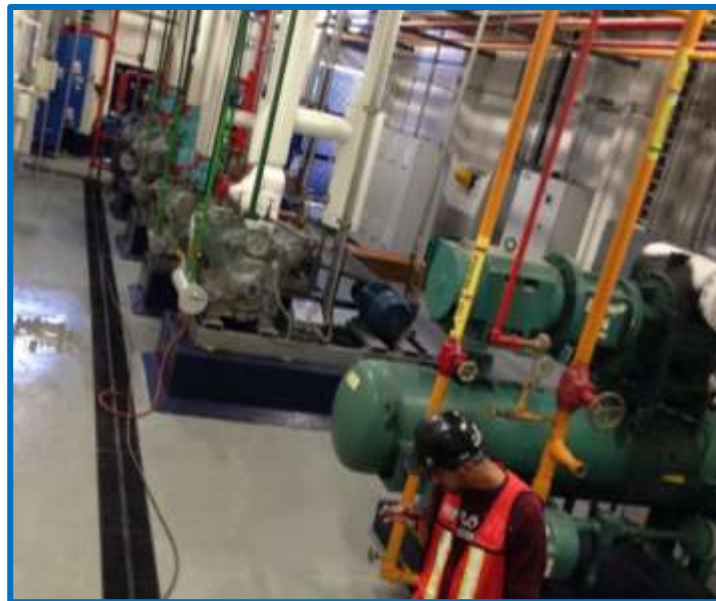
Figura 24. Distribución de equipos en cuarto de máquinas.
