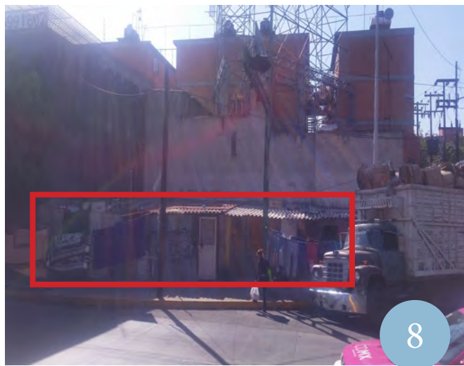
Gráfico 47.-Campo visual 8. Vista desde bajo puente en el cruce de Eje 1 Norte y Circuito Interior, en donde se aprecia claramente el relingo.
