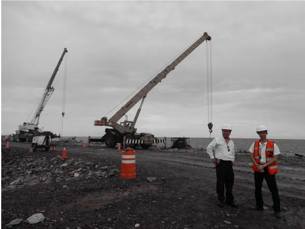
Fotografía 11, Movimiento de rocas para la colocación del Rompe olas
