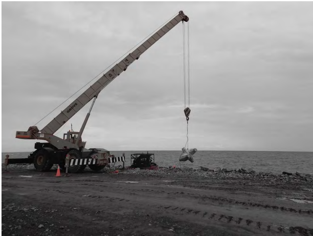
Fotografía 10, Colocación de una sección del Rompe Olas
