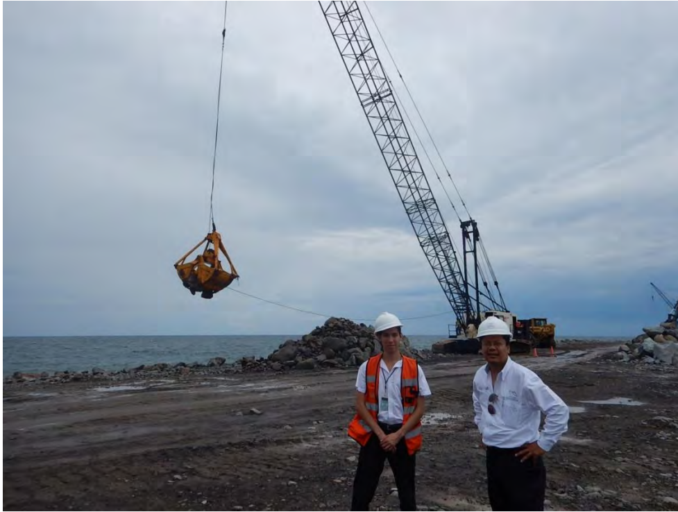
Fotografía 13, Colocación de material en el Rompe Olas
