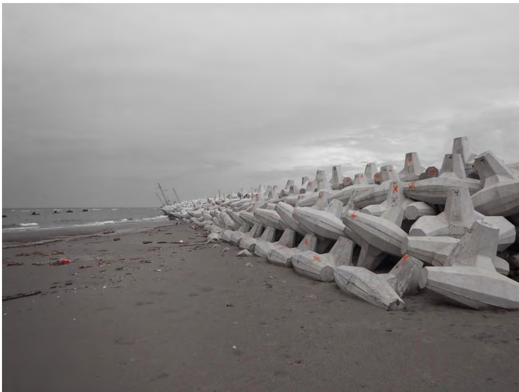
Fotografía 8, Colocación del Rompe Olas norte de la Ampliación
