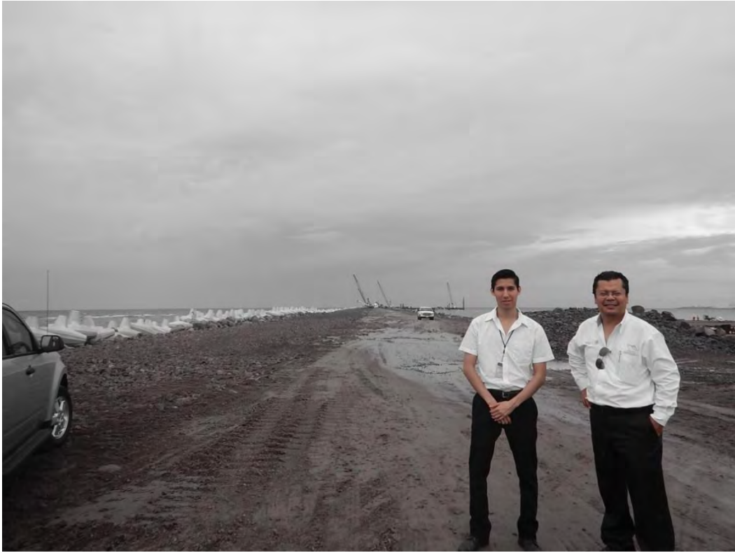
Fotografía 9, Obras de Ampliación
