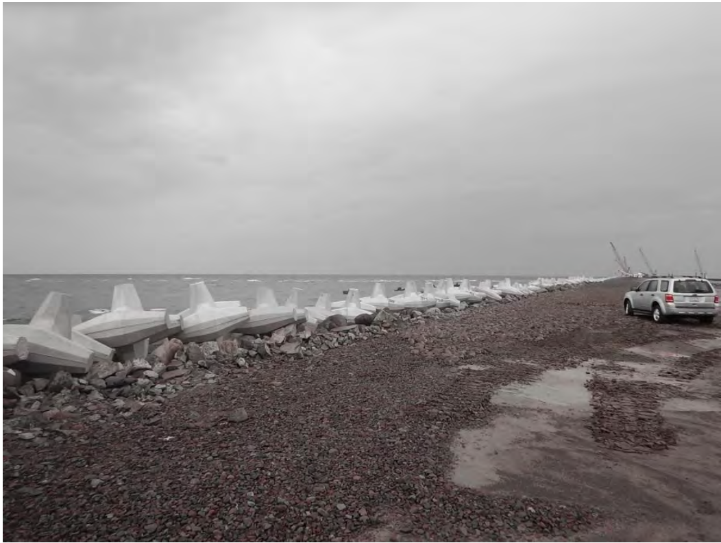
Fotografía 7, Construcción del Rompe Olas norte del proyecto de Ampliación
