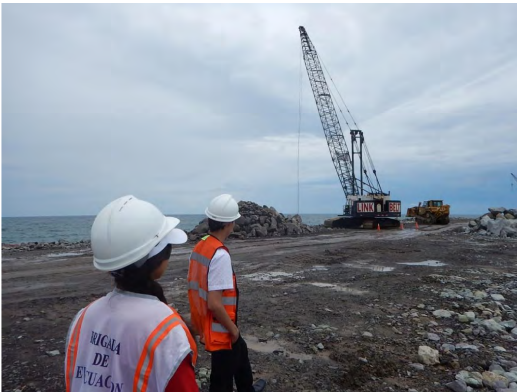
Fotografía 12, Obra de Ampliación del Puerto
