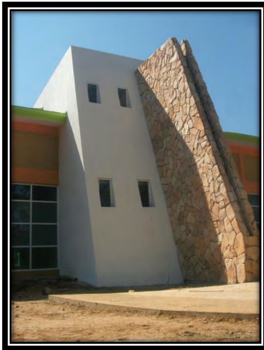
Imagen No. 4: Contrafuertes Fuente: Archivo fotográfico personal
