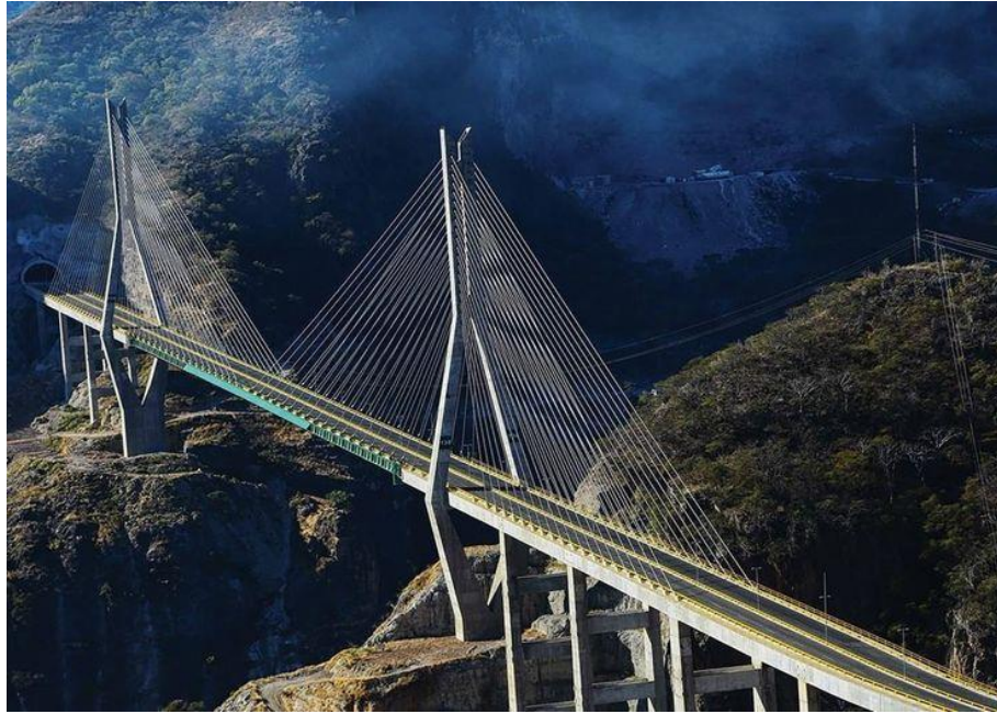
Figura 1.2 Vista del puente Baluarte
