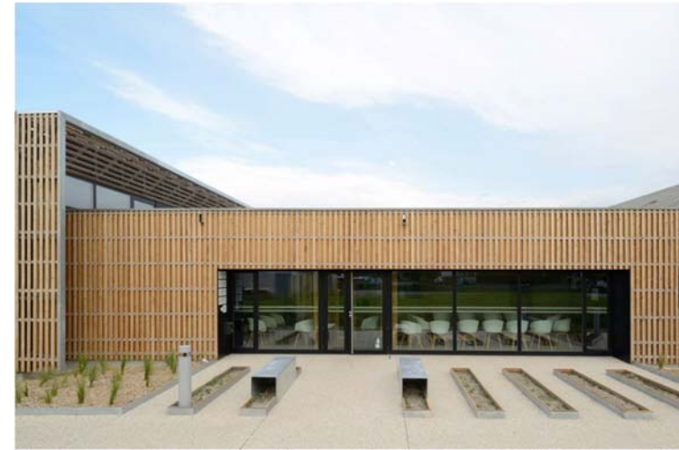
Vista al acceso principal.
