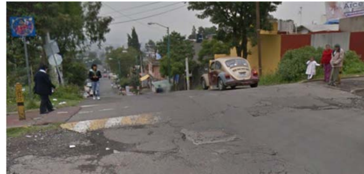
Cruce de la ciclo pista con la av. 35. Se aprecia la falta de mantenimiento y falta de señalamientos para peatones.
