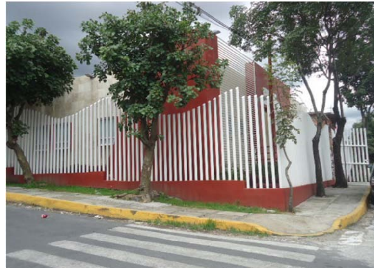
Centro de salud “Hortensia T-1”. Los recursos para este edificio, fueron de mayor capacidad, comparado con los demás centros de salud, en este proyecto intervinieron personas físicas para su mantenimiento y construcción 1 .
