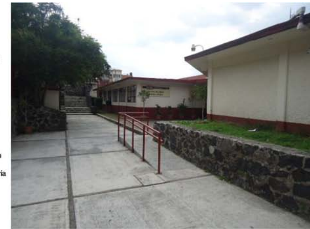
Acceso peatonal al centro de salud "cultura Maya"
