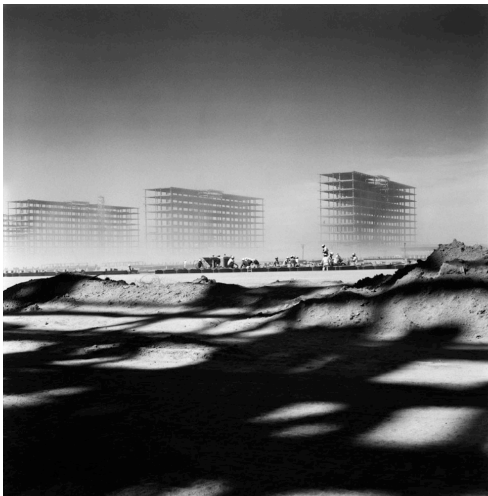
[SUP.] Crystal Palace , construido para la Exposición Universal de 1851 por el experto en horticultura Joseph Paxton, el triunfo del montaje en serie y la complejidad organizativa. [INF.] Construcción de Brasilia, 1953. Proyecto de Lucio Costa y Oscar Niemeyer.
