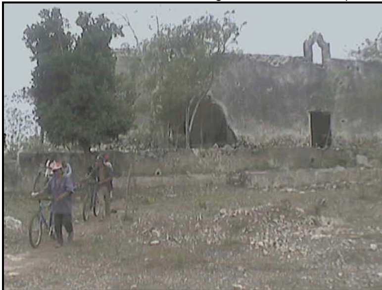
Figura 17. Casco de la Ex Hacienda Anikabil, registrada durante la Etapa I, Zona II o Sur.
