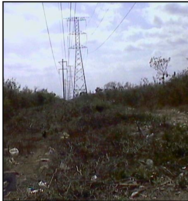
Figura 28. Línea construida en el año 2003, antes del inicio de los recorridos del terreno de Ciudad Caucel.
