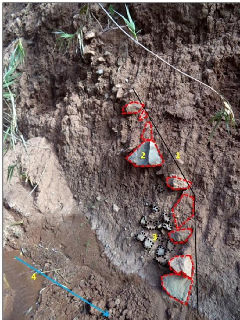
Figura 3.16 Sección transversal de un antiguo lamabordo 1. Lamabordo; 2. Revestimiento exterior de rocas; 3. Revestimiento interior de rocas; 4. Dirección de la corriente.
