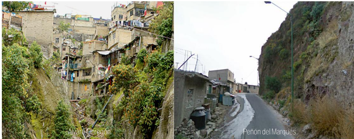
Figura 2.20 Viviendas construidas en zona de riesgo.
