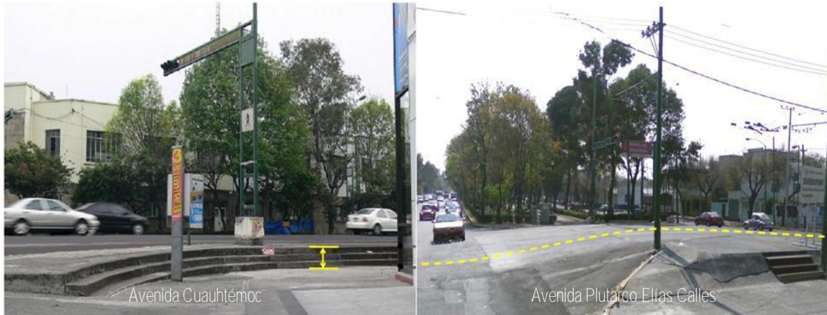
Figura 2.14 Emersión aparente debido a estructuras subyacentes.
