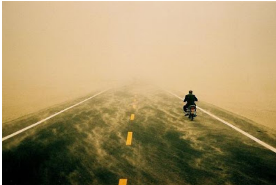
Foto 5: Autopista en las grandes dunas de Taklimakan, la autopista de Tarim, China.
