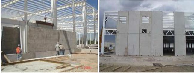
IMAGEN 25.- MUROS PREFABRICADOS.
