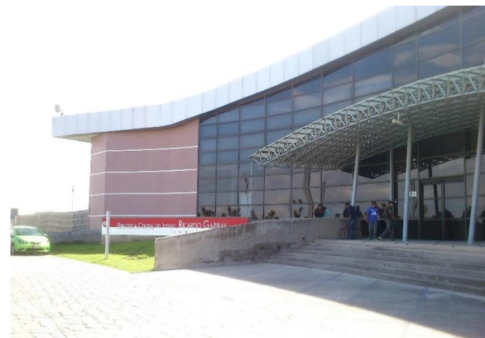
FOTO 9. Vista de la fachada principal. Biblioteca Central del estado de Hidalgo.
