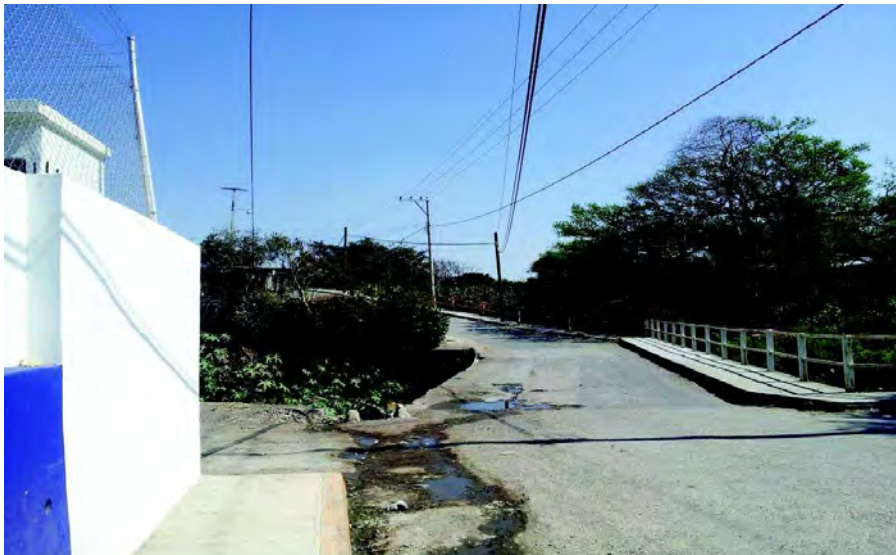
Foto 2. Calle pavimentada sobre la barranca.
