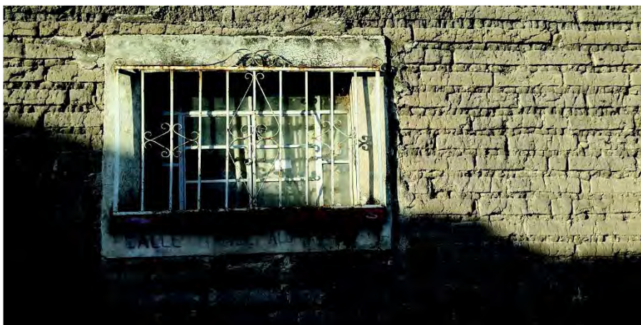
Foto 1. Fachada de casa construída con adobe.
