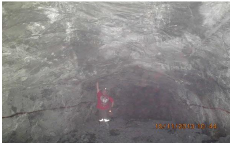
Figura 4.33 Altura en rebaje controlada (Campaña 6A)
