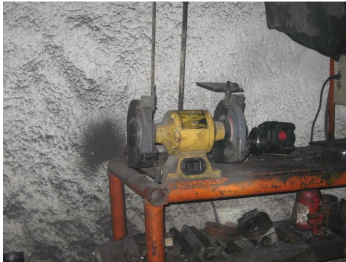
Figura 4.9 Peligros y riesgo en campo, taller diésel Tecolotes N-16
