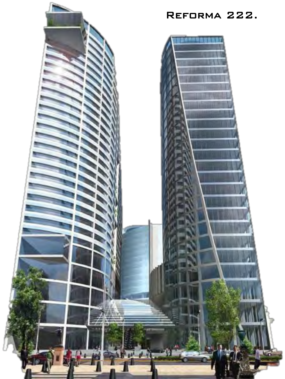
FACHADA REFORMA 222. FUENTE: CODIGO REFORMA.
