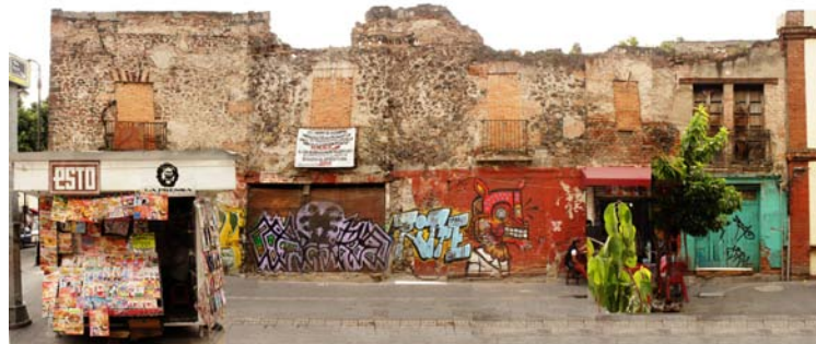
IMAGEN 09. Fachada actual sobre la calle Roldán.
