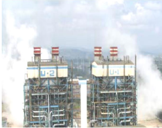
Figura 3. 2 Unidades 1 y 2 de la Central Termoeléctrica “Francisco Pérez Ríos” vista de las chimeneas de las unidades.
