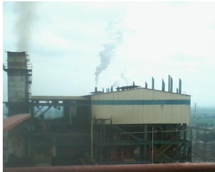
Figura 3. 3 Vista lateral de la Unidad 2, durante la visita de trabajo.
