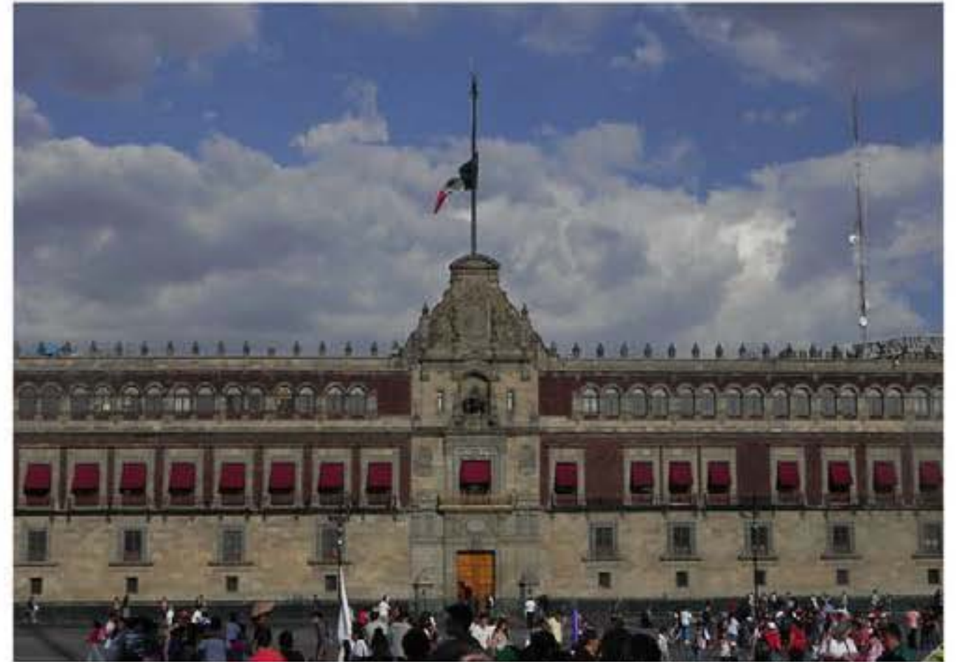
3.6 Fachada principal del Palacio Nacional. Centro de la Ciudad de México, México.
