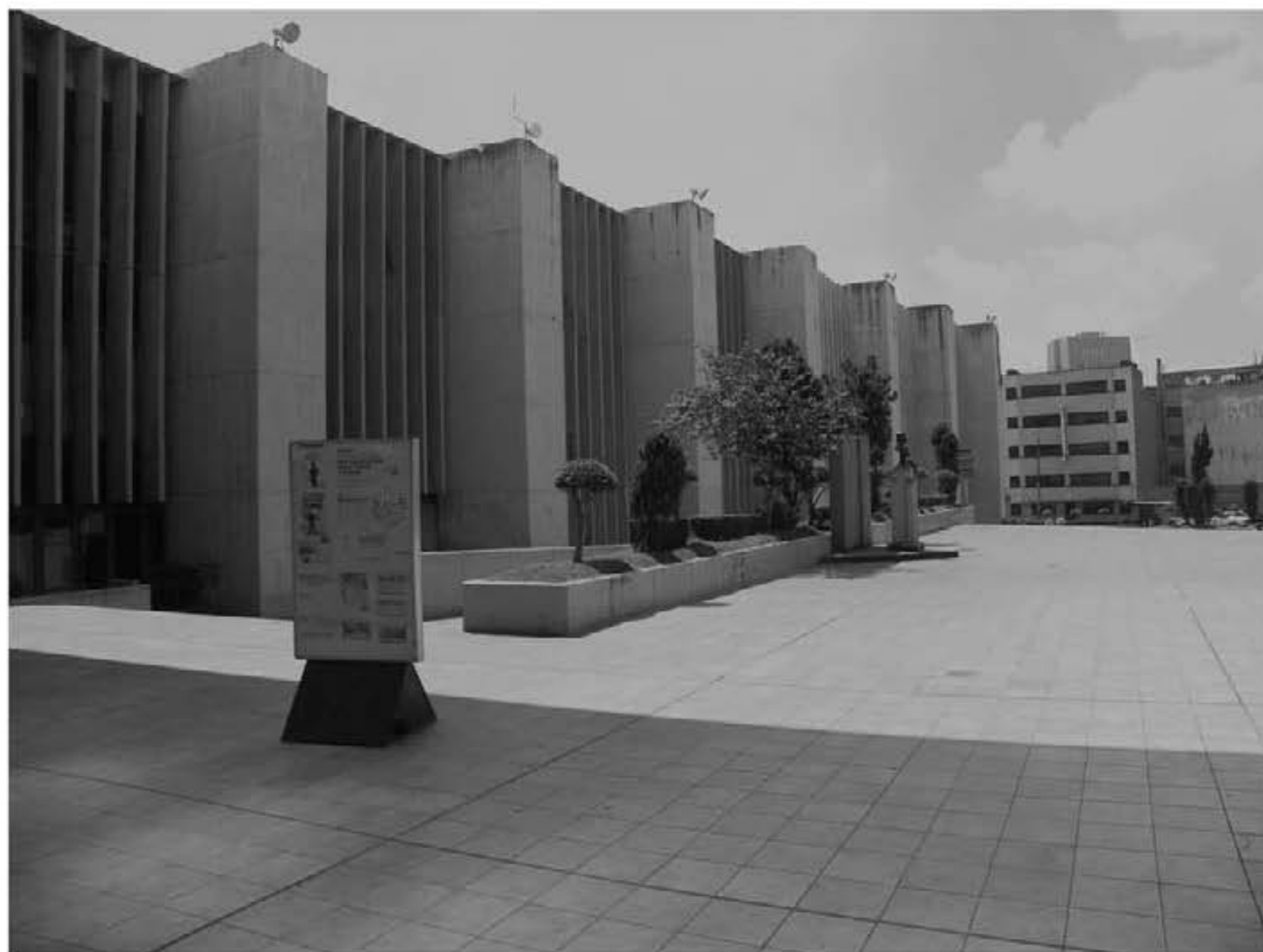
5.1 Edificio de la delegación Cuauhtémoc. Ciudad de México, México.
