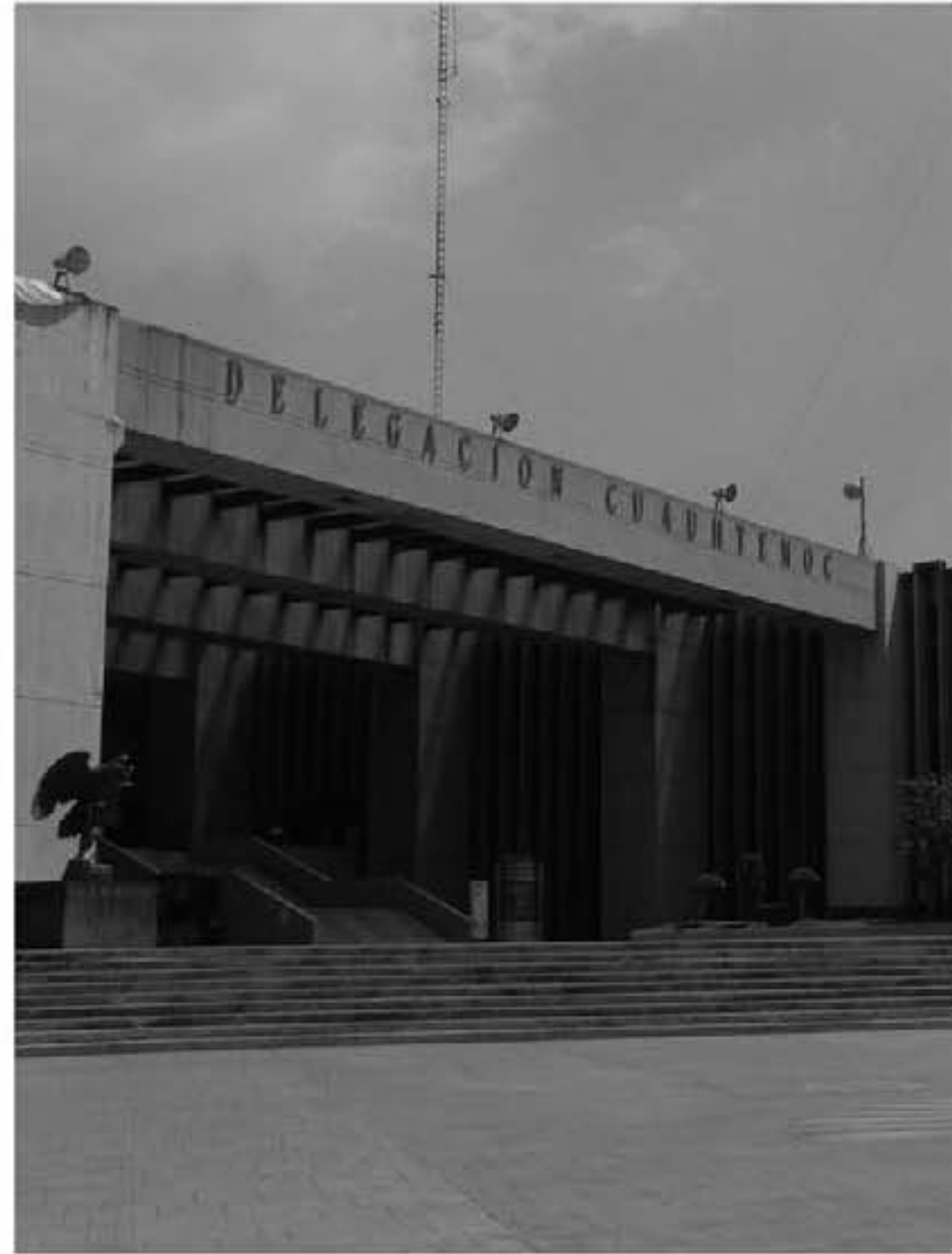
6.3 Edificio de la delegación Cuauhtémoc (acceso principal). Ciudad de México, México.
