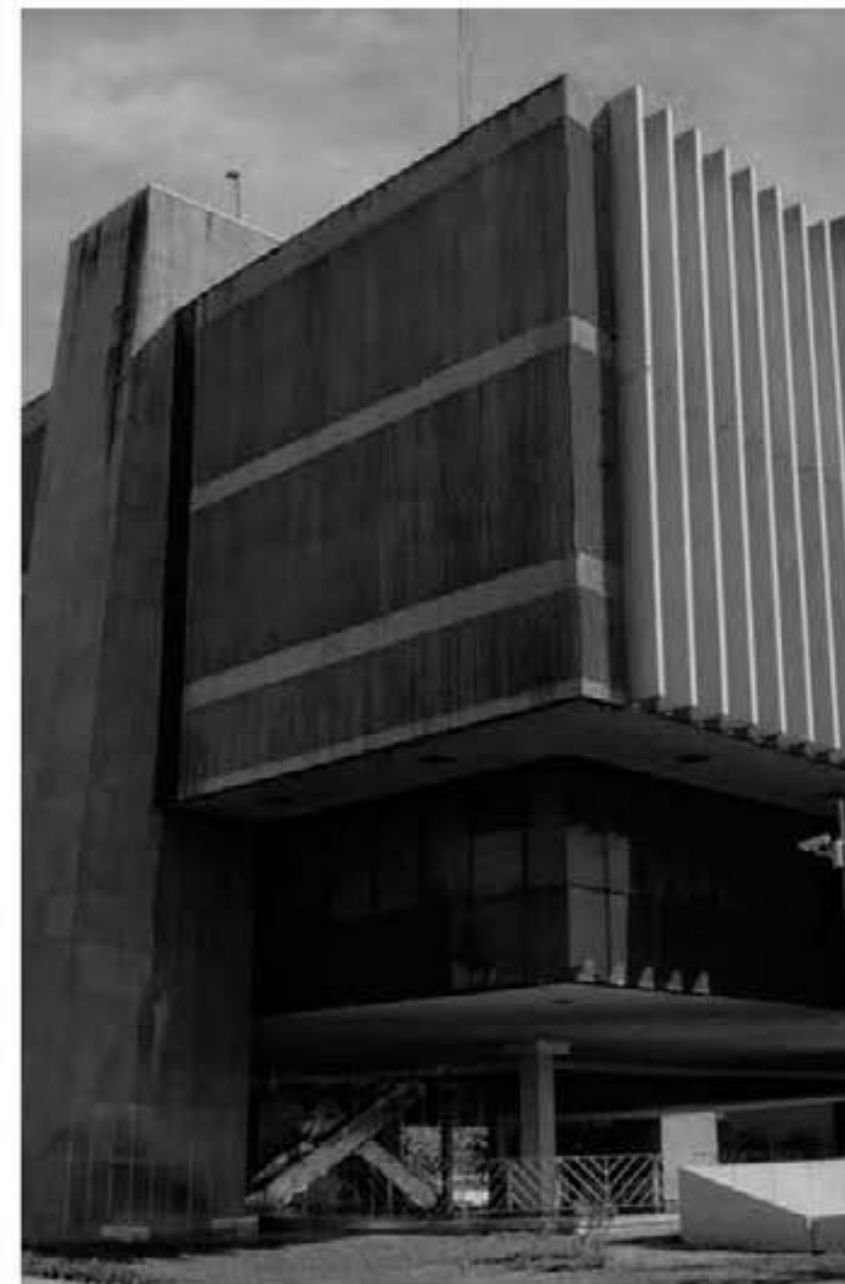
6.6 Vista posterior de la presidencia Municipal de Monterrey Nuevo León, México
