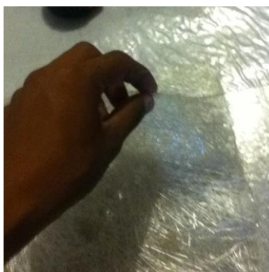
Figura 4.4 Aplicación de nueva capa de fibra
