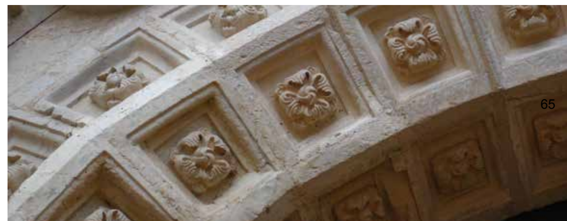
48. Detalle de casetones, Coixtlahuaca, Oaxaca
