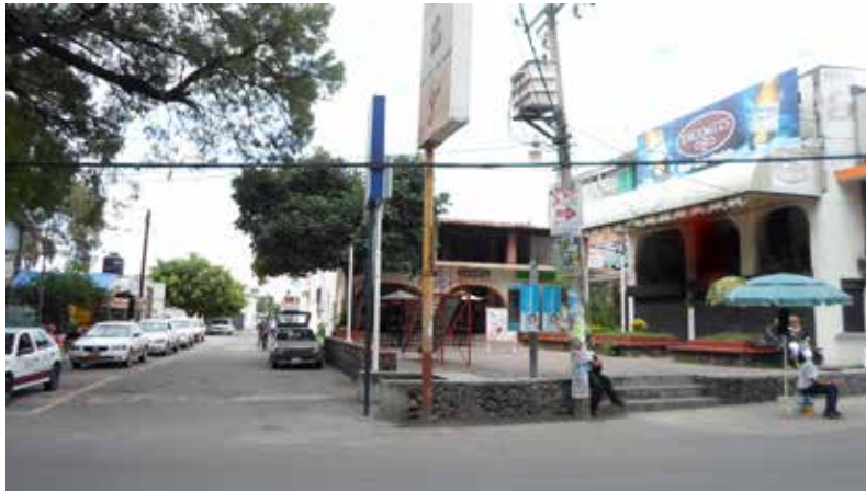
112. Estado actual esquina Ermita con Profesor Rómulo H.
