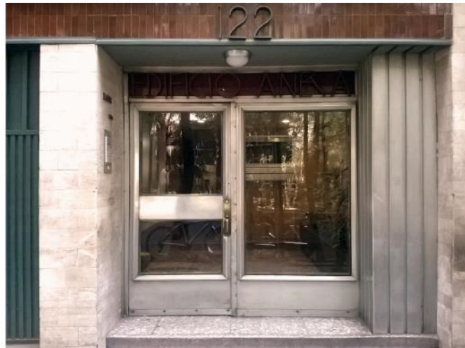
Figura 196: Vista de la entrada del edificio ubicado en Ámsterdam núm. 122, 2015
