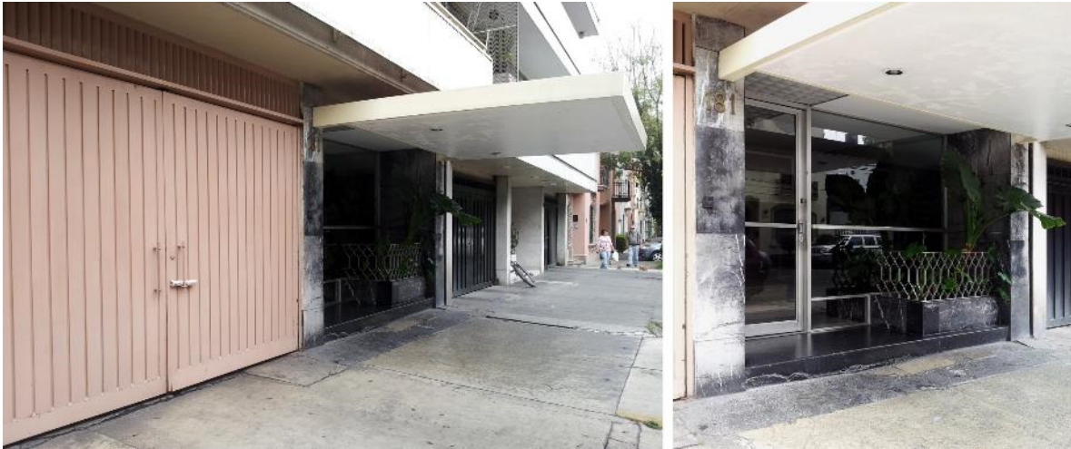
Figura 173: Ejemplo prototípico de marquesina de entrada que diseñó el ingeniero Boris Albin en el edificio ubicado en Cuernavaca núm. 181. Aunque la entrada y marquesina presentan modificaciones, aun se observa la dimensión original del voladizo de la cubierta.
