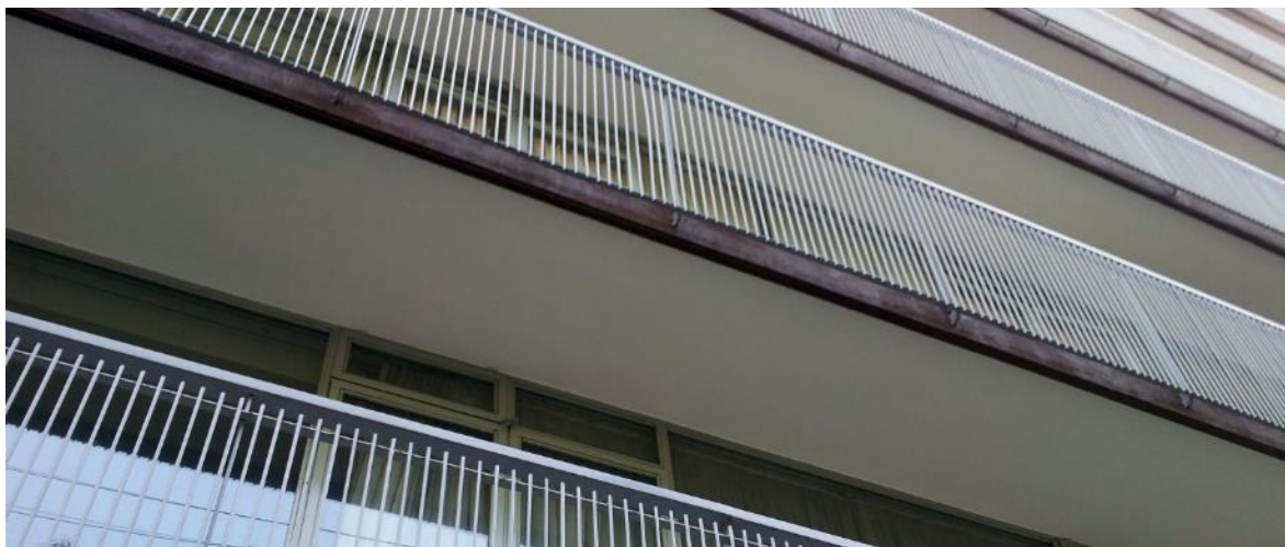
Figura 238: Vista de los balcones del edificio ubicado en Mazatlán núm. 36. Edificio proyectado por el ingeniero Boris Albin en 1968, el cual se encuentra en el 2015 en muy buen estado de conservación.
