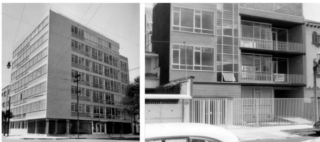
Figura 190: Par de vistas de las fachadas de los edificios ubicados en Agustín Melgar núm. 42, ca.1952 y Aristóteles núm. 225, ca.1954
