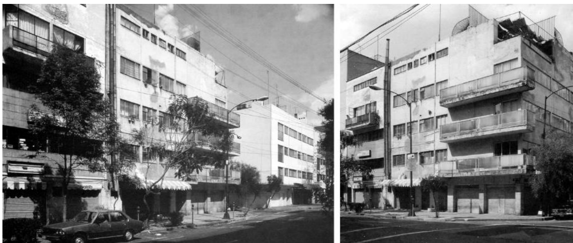
Figura 60: Vistas de las fachadas de los edificios de apartamentos ubicados en la calle de Río Elba núm. 38, 50, 56 y 59, ca.1940. Siendo cuatro edificios independientes conforman un conjunto urbano funcionalista.
