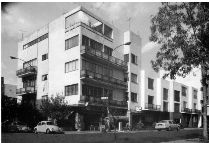
Figura 17: Edificio y casas Figueroa Uriza del ingeniero arquitecto Luis Barragán, ubicadas en Sullivan núm. 57, colonia San Rafael, Ciudad de México, 1940. Se observa el fenómeno de “convivencia” entre edificios de apartamentos y casas unifamiliares desarrolladas en una misma colonia, en un mismo momento, y por el mismo autor, todos destinados a la renta.
