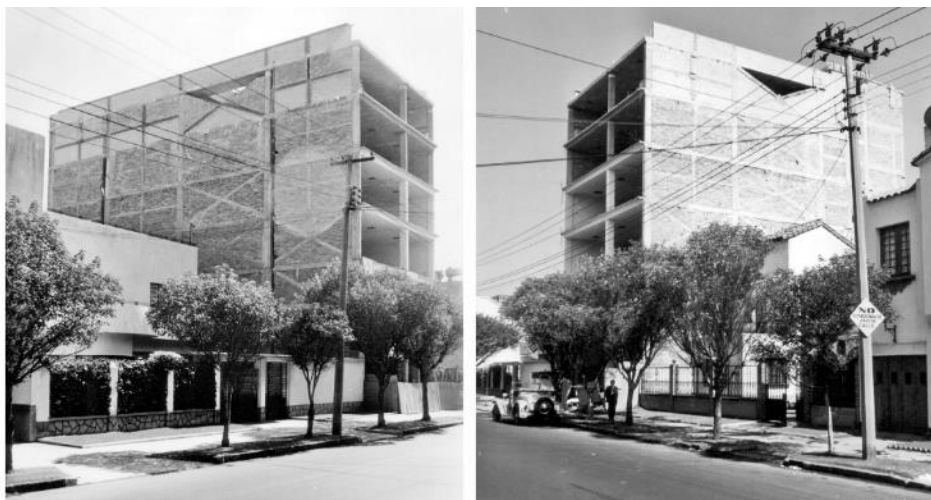
Figura 161: Vistas del “huacal” de un edificio de apartamentos en construcción del ingeniero Boris Albin, ubicación y fecha desconocidos. Se observa la estructura porticada en concreto armado. Sistema estructural y constructivo que se convirtió en el sistema hegemónico en la segunda mitad del siglo XX en la vivienda en general y particularmente en la de carácter colectivo y vertical.
