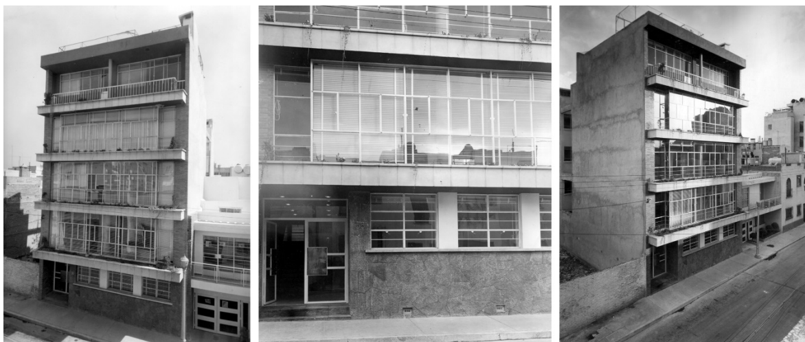
Figura 182: Tres vistas de la fachada del edificio ubicado en Puerto Real núm.38, fotógrafo A. Escobar, enero 1954
