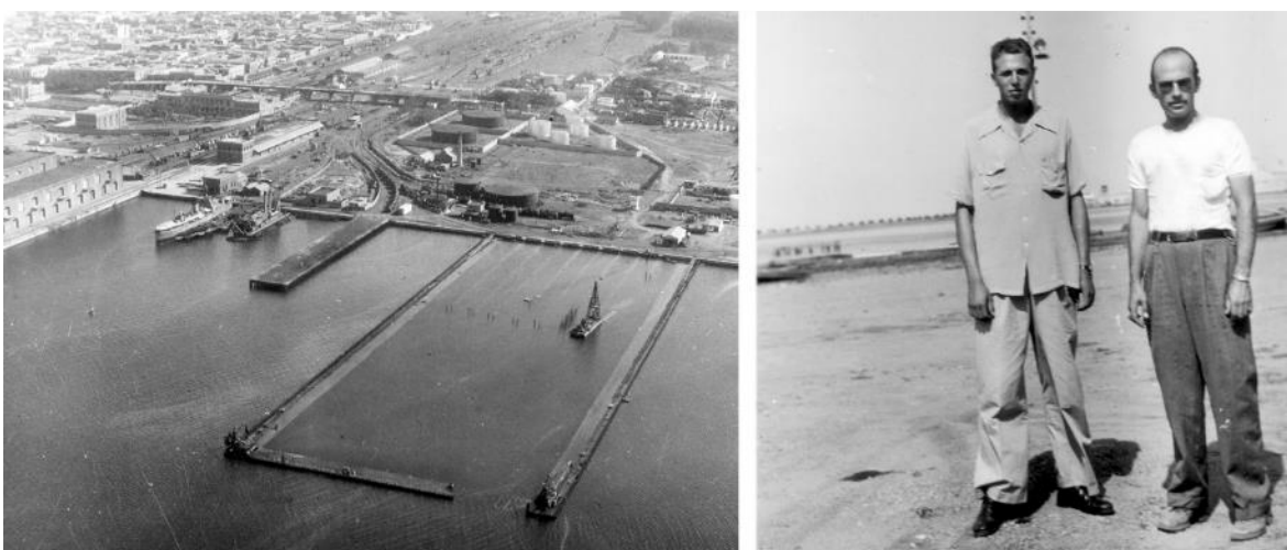
Figura 125: A la izquierda, vista aérea de las obras portuarias en que participó el ingeniero Boris Albin en Veracruz; a la derecha, fotografía de Boris Albin con su jefe y maestro el ingeniero Roberto Mendoza Franco en Veracruz, ca. 1949
