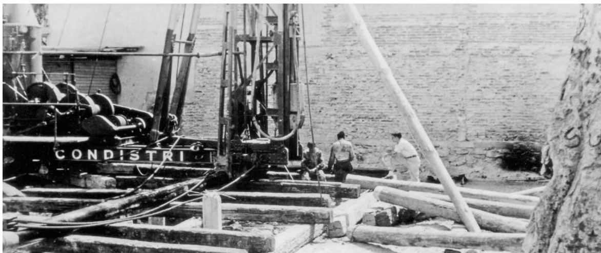
Figura 162: Vista del hincado de pilotes por la compañía Condistri en una obra del ingeniero Boris Albin, ubicación y fecha desconocidas
