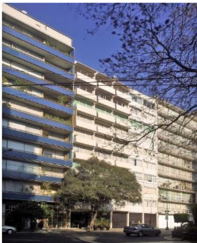
Figura 148: Vista actual de la calle de Hegel en la colonia Chapultepec Morales (Polanco), se observa la consolidación de un paramento urbano de diez niveles entre 1950 y 1970, a partir de la sucesión de edificios de apartamentos, dos de ellos (los de los extremos) del ingeniero Boris Albin; un escenario urbano muy distinto al de una ciudad anteriormente más bien baja donde los edificios de apartamentos no rebasaban los cuatro niveles como se aprecia en la figura 141.
