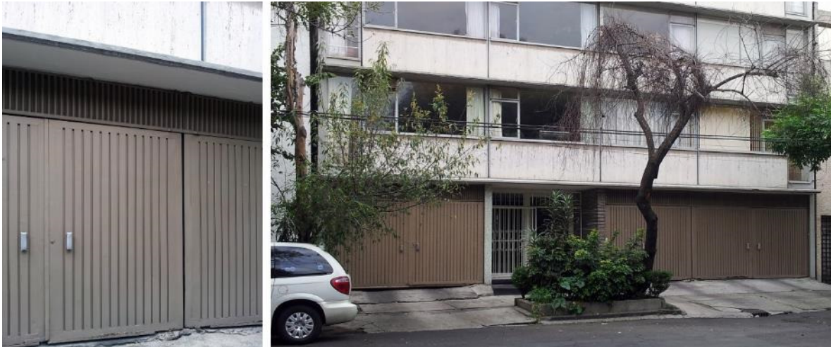
Figura 176: Ejemplo de zaguán de garaje de coches en el edificio ubicado en Juan de la Berrera núm. 62, 2014. Se observa el uso de lámina acanalada en puertas y una celosía fija superior que permite la ventilación del estacionamiento pero preserva la privacidad.
