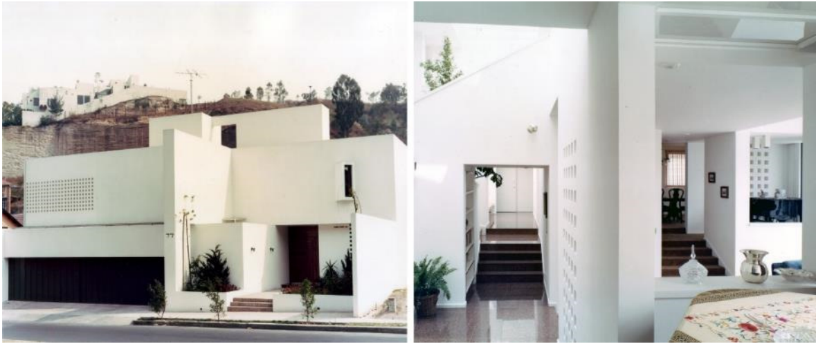
Figura 134: Paseo de Ahuehuetes núm. 77, ca. 1977. Una obra del ingeniero Boris Albin en colaboración con los arquitectos Enrique Albin y Enrique Norten. Ambos arquitectos fueron alumnos del arquitecto José María Buendía, quien hizo escuela a finales de la década de los setenta promoviendo una arquitectura moderna con raíces vernáculas, en particular las andaluzas, de ahí la importancia del color blanco, de la predilección del macizo sobre el vano, de los cambios de niveles y la importancia de los patios interiores en estas casas.
