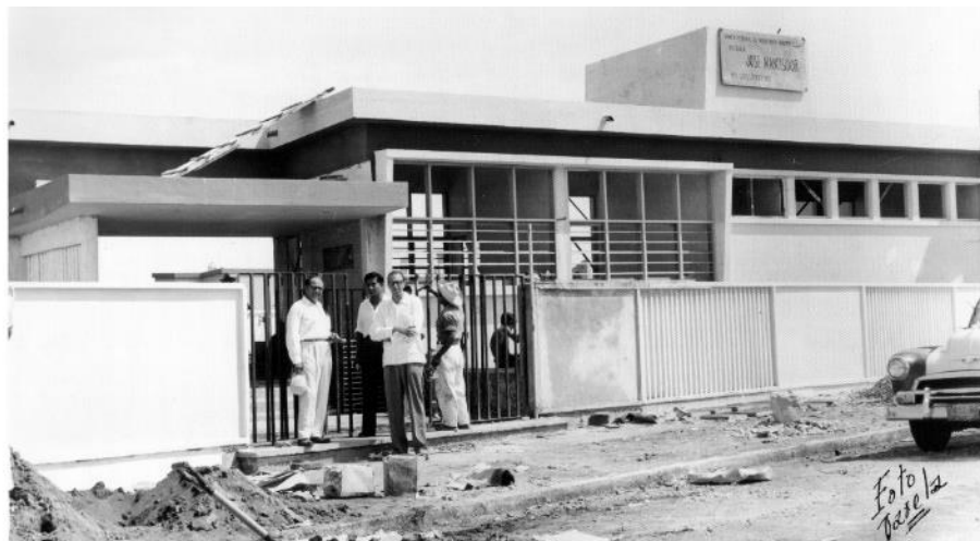
Figura 126: Vista de la construcción de la escuela pública primaria José Mancisidor. Se aprecia en la foto al ingeniero Boris Albin.
