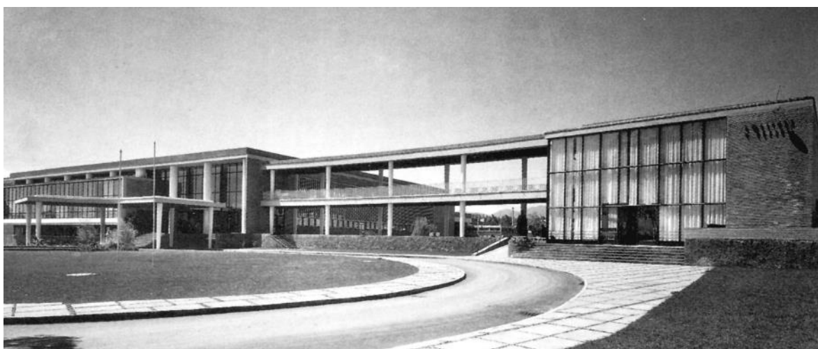
Figura 143: Vista de la fachada principal del Centro Deportivo Israelita del arquitecto Vladimir Kaspé, ca.1958
