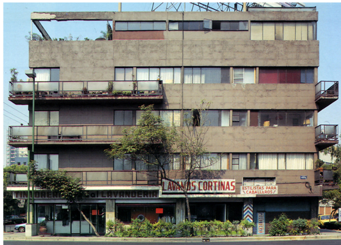
Figura 61: Vista de la fachada del edificio de apartamentos "Garza" del arquitecto Luis Barragán en colaboración con José Creixell, ubicado en la plaza de Melchor Ocampo núm. 40, ca.1940
