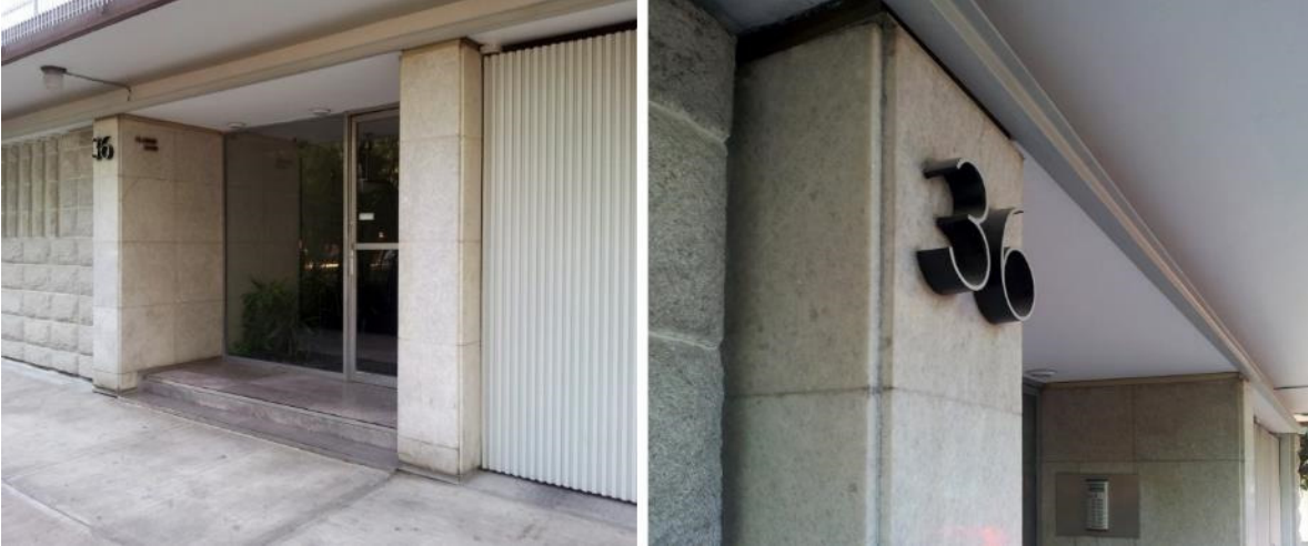
Figura 177: Vistas de la entrada del edificio ubicado en Mazatlán núm. 36, 2014. Se observa el nivel de detalle que diseñó el ingeniero Boris Albin en las juntas entre materiales, así como la entrecalle en el arranque y remate de lambrines y plafones.
