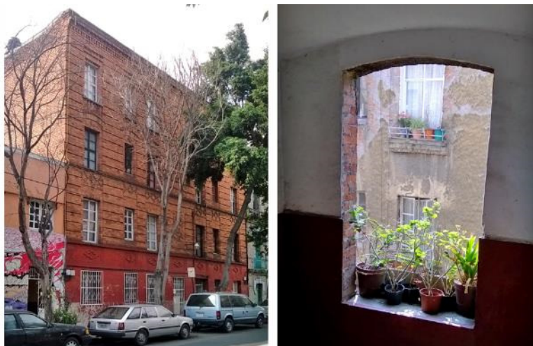
Figura 34: Fachada e interiores del edificio ubicado en Dr. Atl núm. 273, 2015. Ejemplo de un multifamiliar para empleados y obreros ca. 1900.
