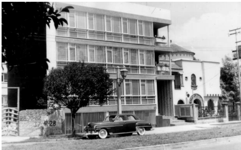
Figura 152: Vista de la fachada del edificio en Campos Elíseos núm.93 del ingeniero Boris Albin, 1953
