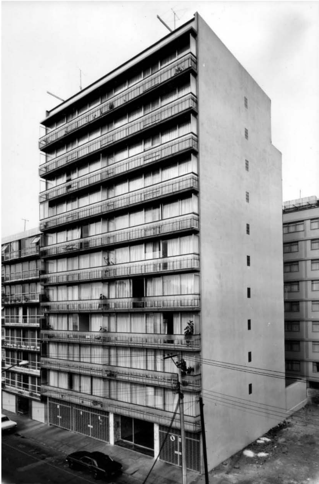
Figura 1: Vista de la fachada del edificio de apartamentos ubicado en Bernard Shaw núm. 22 diseñado y construido por el ingeniero Boris Albin. Fotografía de H. Mejía, ca. 1966. Este edificio pertenece al periodo más representativo de su obra, donde se observa el esquema de “balcones corridos a manera de marquesina con cancelos de piso a techo”.
