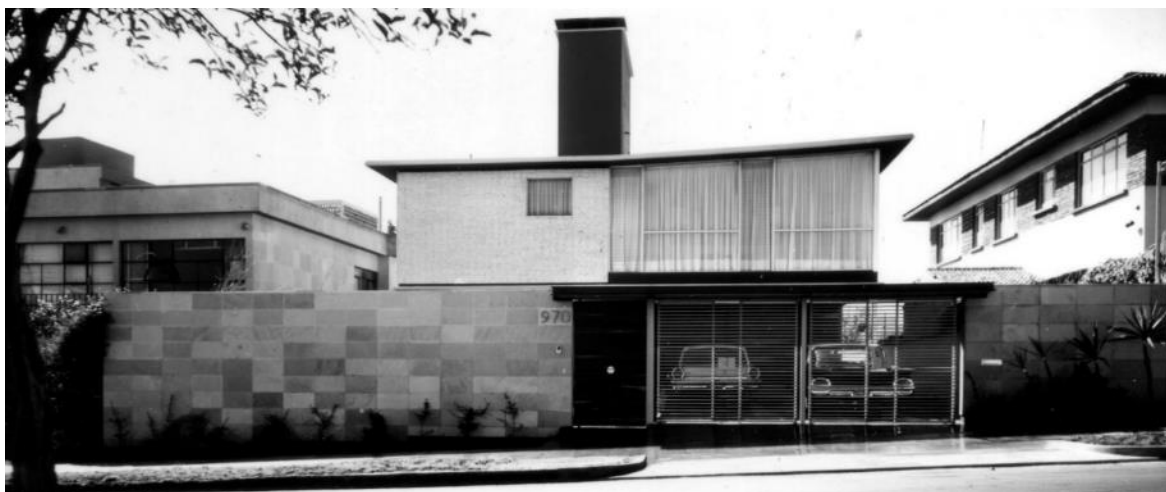
Figura 3: Vista de la fachada de la residencia en Avenida de las Palmas núm. 970, diseñada y construida por el ingeniero Boris Albin. Fotografía H. Mejía, ca. 1963.
