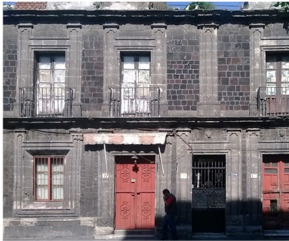
Figura 26: Vista de la fachada de las Casas de los Camilos, 2014.
