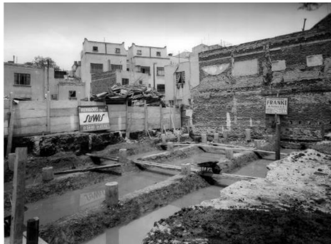
Figura 207: Vista de la construcción del edificio ubicado en Agustín Melgar núm.33, ca.1956. Se observan las cabezas de los pilotes recién hincados, así como dos anuncios, uno de los elevadores SUWIS y el otro de cimentaciones FRANKI, empresa que realizó las obras de piloteado.
