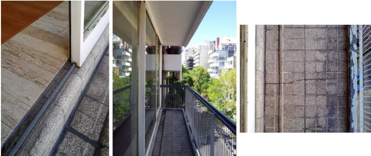
Figura 171: Balcón/marquesina en el edificio ubicado en Lope de Vega núm. 333, 2014. Se observa un diseño simple pero repleto de detalles funcionales, por ejemplo: el balcón tiene una leve pendiente hacia adentro por la que se conduce el agua hacia un canal para desecharla por una BAP oculto; el barandal está colocado a manera de ‘parche’ para que no acumule agua el balcón y simplemente la tire; el perímetro del balcón tiene un pequeño pretil para que no escurra agua por el canto de la losa; se observa al interior que existe una franja recubierta con mármol como elemento de transición entre el acabado interior (originalmente alfombra) y el exterior loseta de terrazo; por debajo, la losa que forma la marquesina tiene un generoso gotero que fue integrado en el colado original y unos drenes apenas visibles que permiten drenar la acumulación de agua entre la losa y el acabado del balcón, por mencionar algunos.
