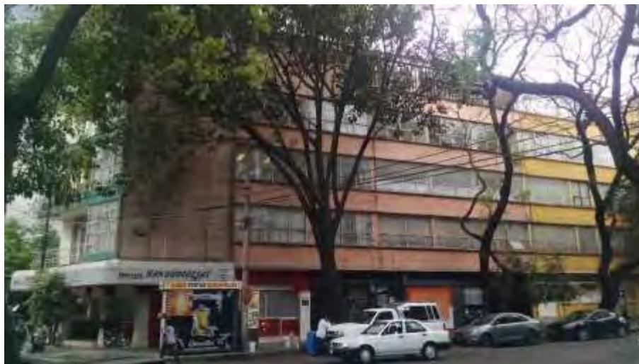
Ilustración 22: Proyecto de remodelación en la calle de Eugenia, Colonia Nápoles, Ciudad de México
