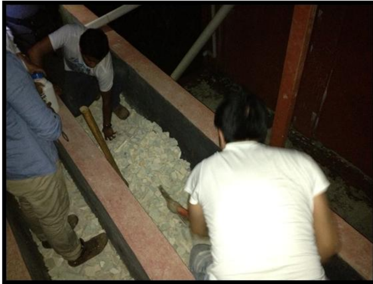
Figura 41. Habilitación de la PTAR en HFSS, colocación de sustrato en módulos del humedal.
