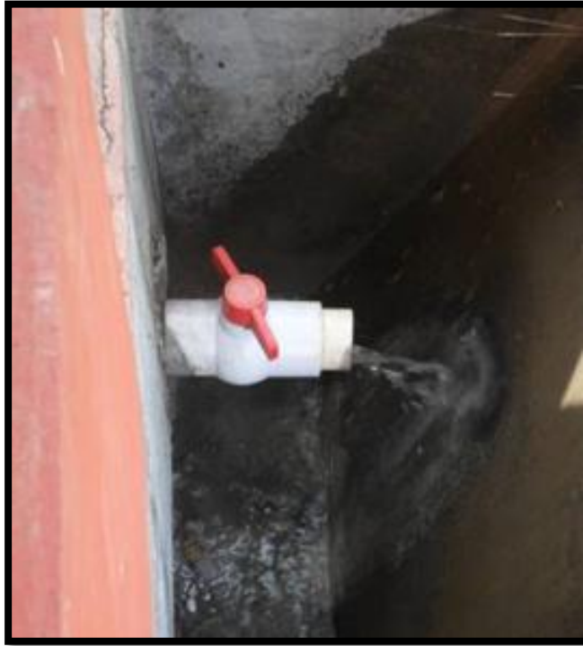
Figura 44. Llave de paso para ajuste el desalojo del efluente
