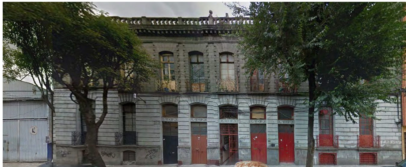
Privada en Enrique González Martínez No. 177 al centro se ubica el acceso a las viviendas del interior.
