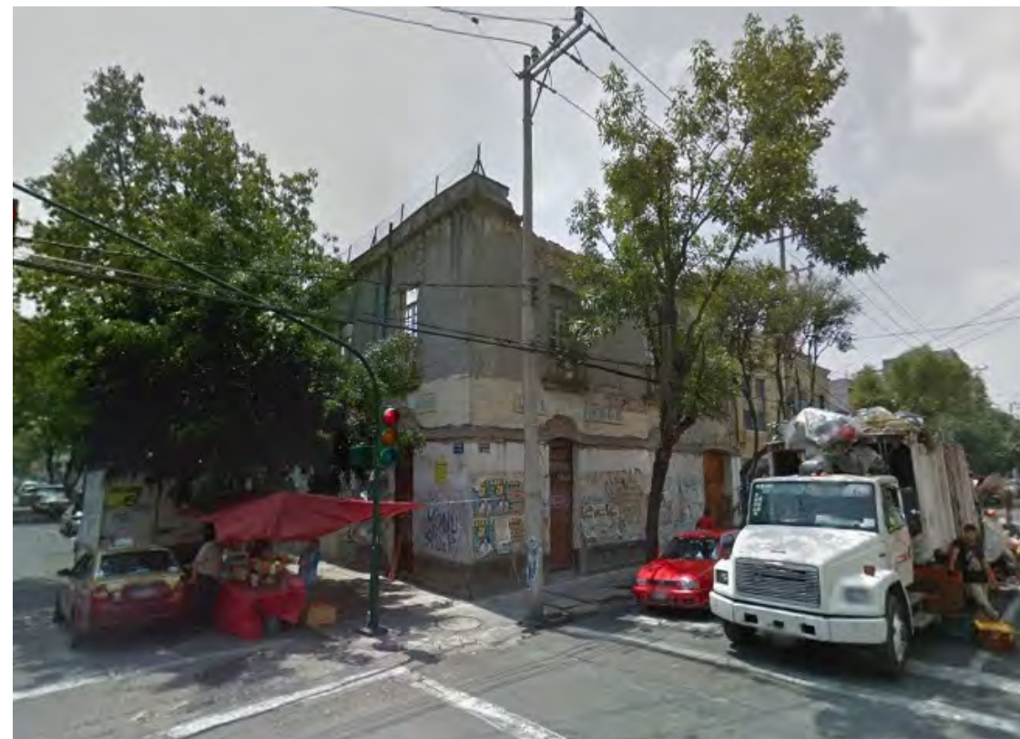
Deterioro y abandono experimentan varias construcciones dentro de la colonia, situación que se agrava dada la presión inmobiliaria que experimenta la zona. Esquina de Naranjo y Carpio.
