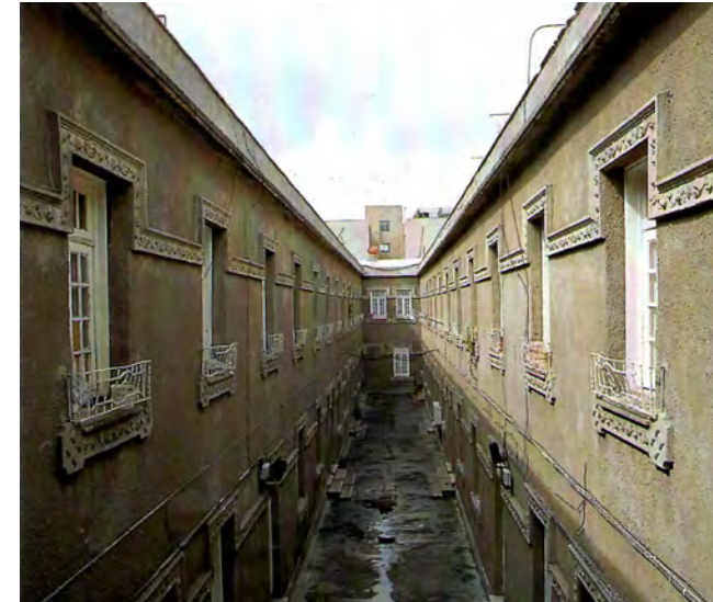
Interior de Cedro No. 56 se conserva el patio central y las habitaciones se distribuyen en dos niveles con acceso propio a partir de dicho patio.
