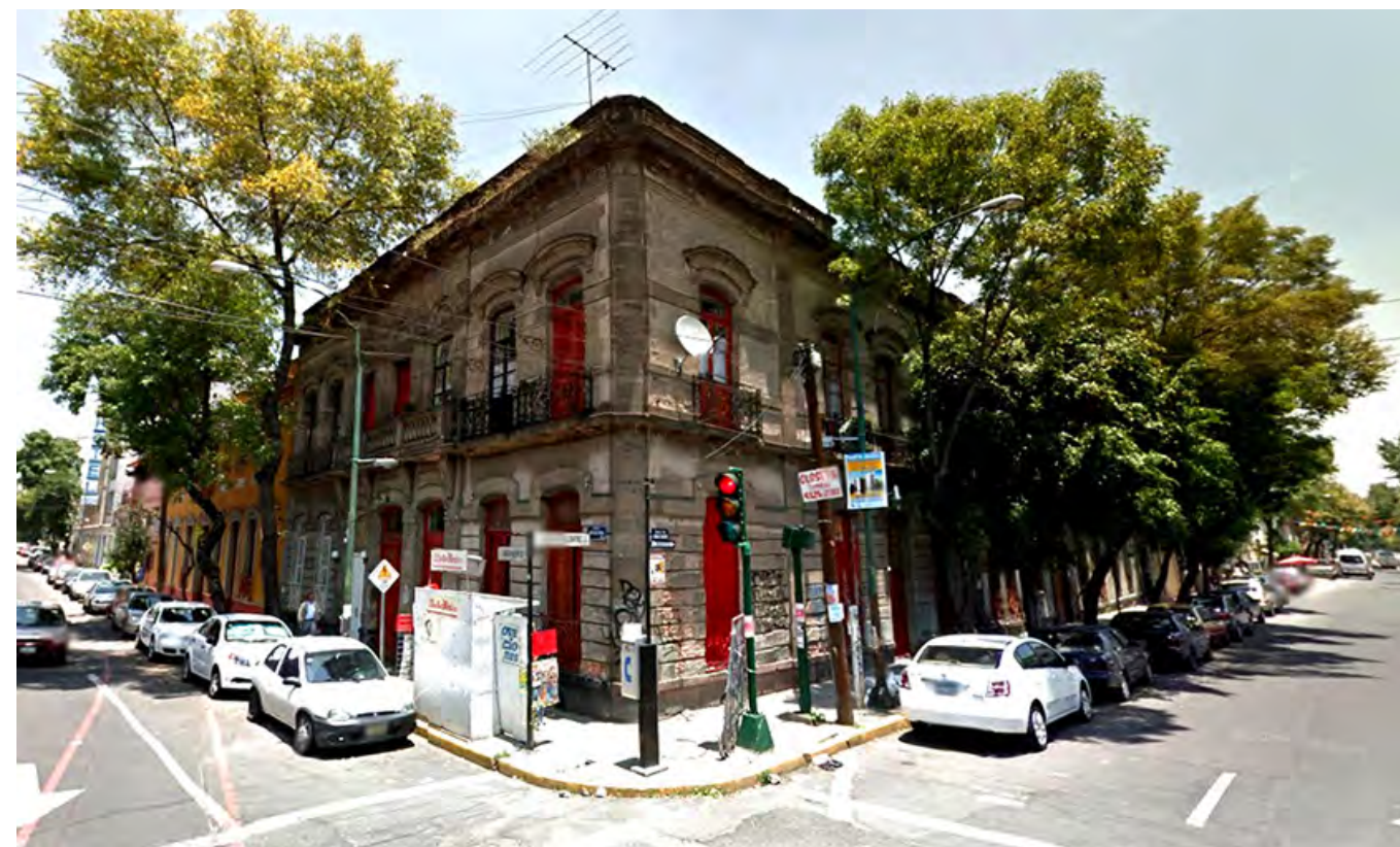
Edificio de Uso Mixto / Santa María la Ribera Tipología de vivienda
