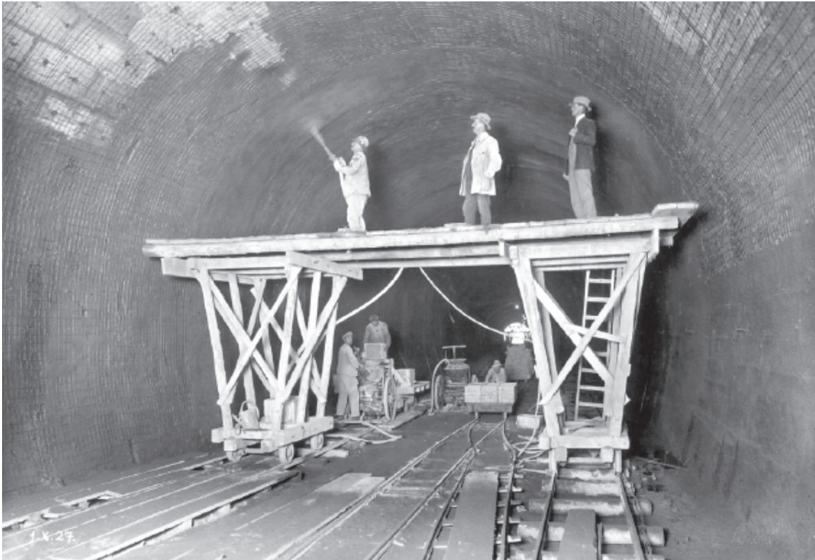
Figura 3. Concreto lanzado en el túnel Ulmberg en Zúrich, Suiza, 1927. Imagen extraída de Kovári, (2003).
