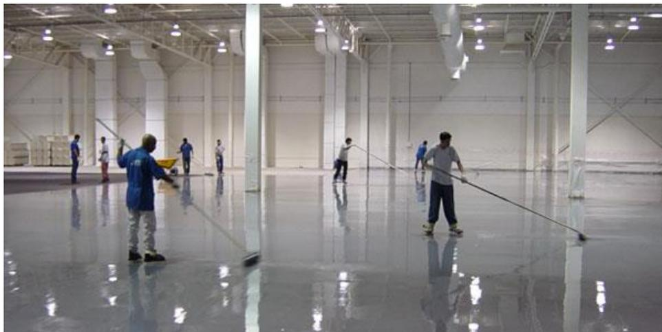
**Figura 2.9-** Ejemplo de recubrimiento epóxico
