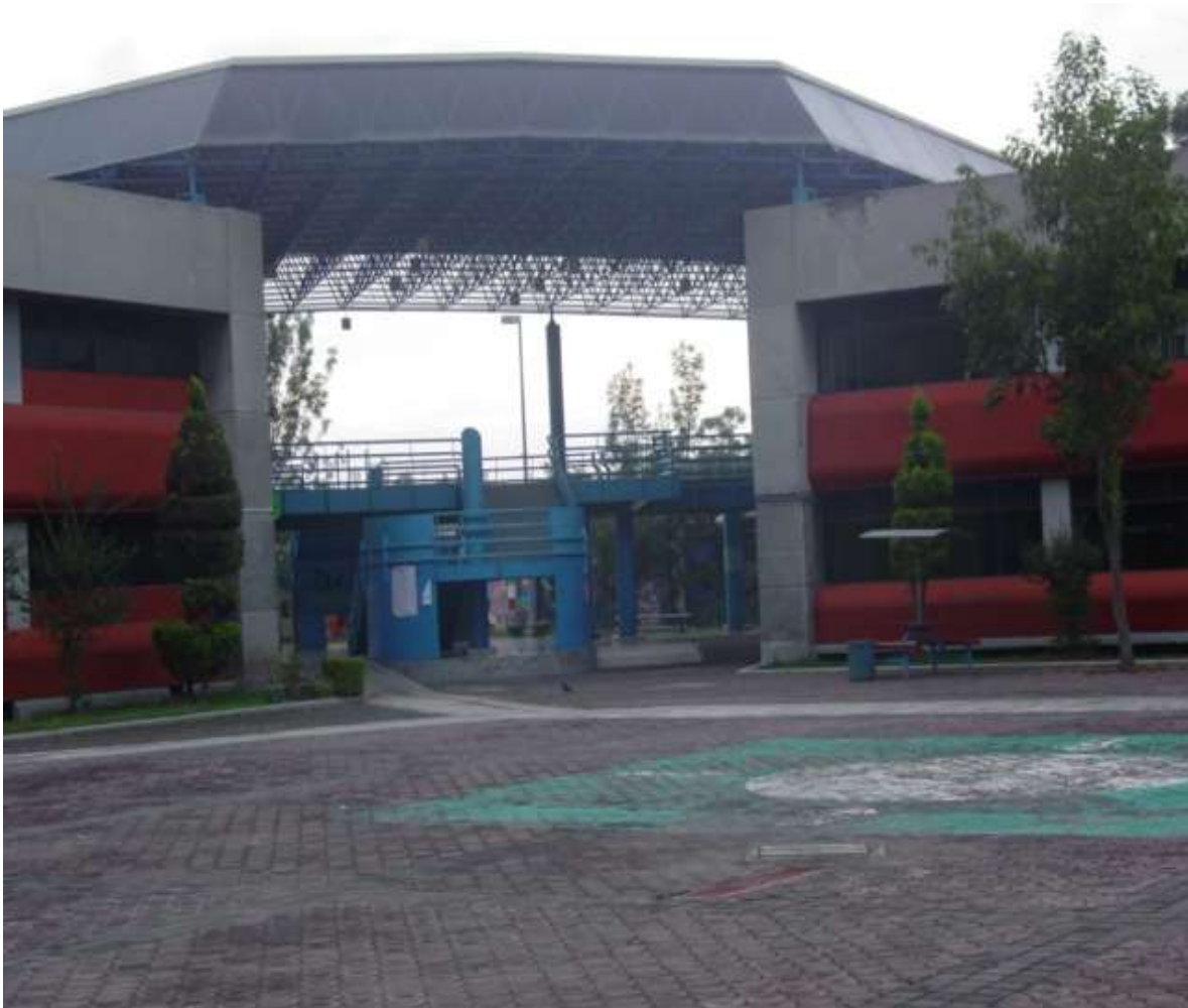
Foto 2. Edificio A, sección B lado izquierdo se ubica la biblioteca
