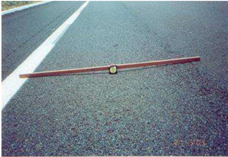
Ilustración 9 Medición de la profundidad de rodera mediante la regla de tres metros
