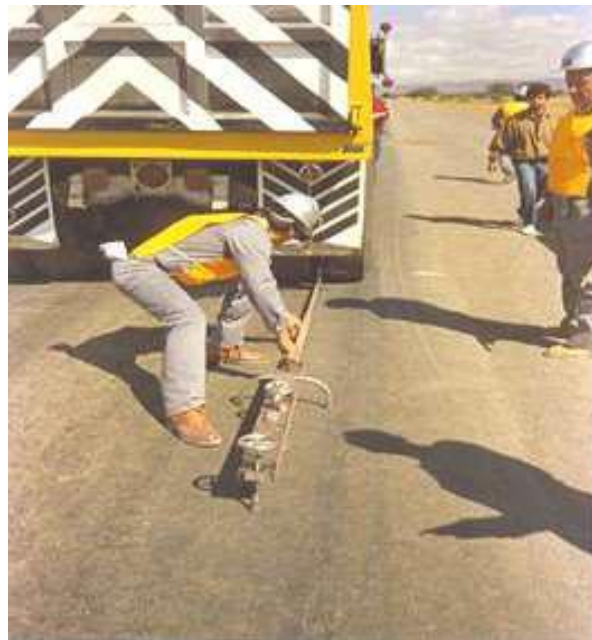
Ilustración 18 Evaluación estructural de un pavimento flexible mediante la Viga Benkelman
