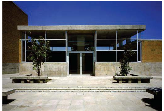
28.- En el proyecto predomina el concreto como material.
