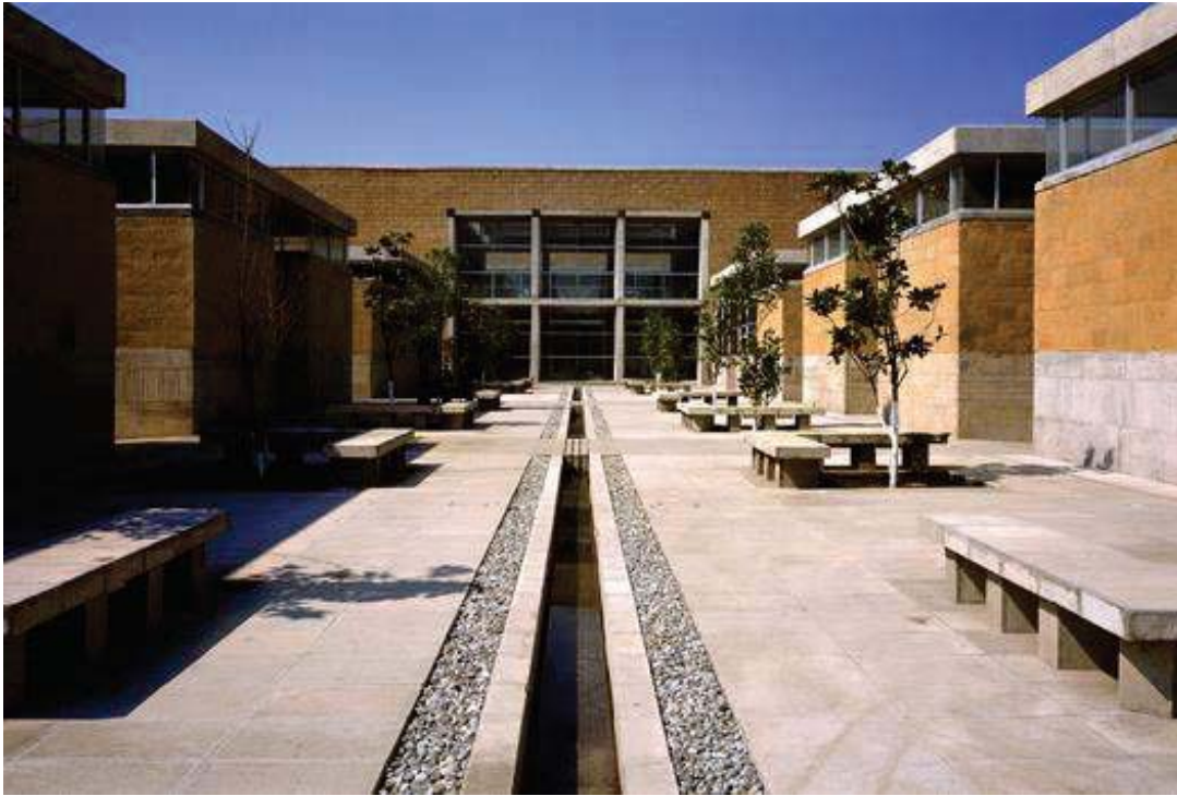
26.- Fachada del Centro de invidentes y débiles visuales.
