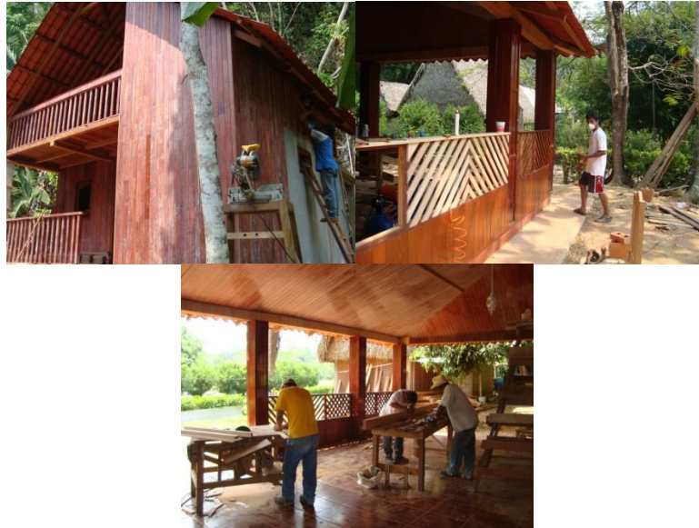
Figura 52. Construcción de cabañas y restaurant en Cerro Chango, fotos Abel Toledo.
