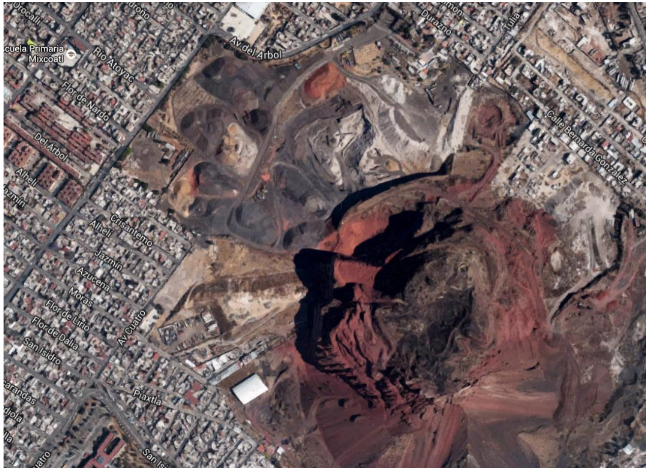
Figura 15. Planta Concretos reciclados, esta planta se ubica en el Distrito Federal en la demarcación de la delegación Iztapalapa, en la Avenida del Árbol No. 106
