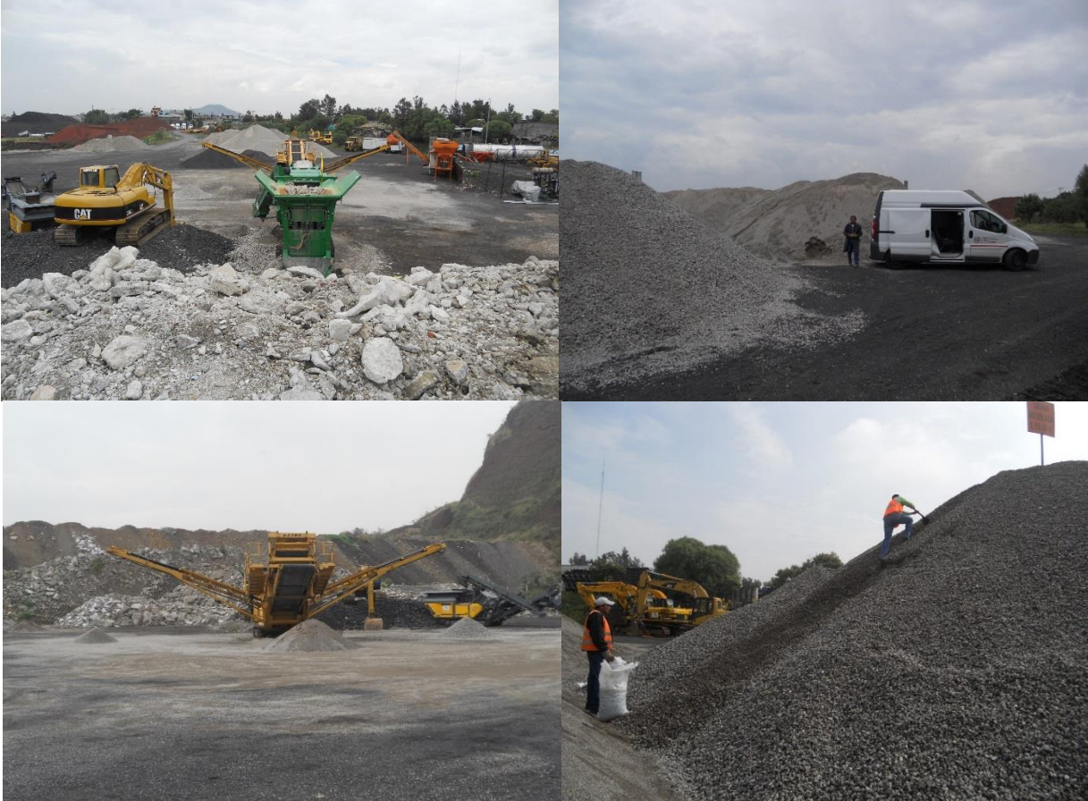
Figura 16. Planta de concreto reciclado, almacén de concreto simple o armado
