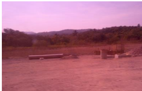
Actual Del Terreno Primera Etapa Del Proceso De Construcción De Las Obras De Urbanización Que Requiere El Proyecto
