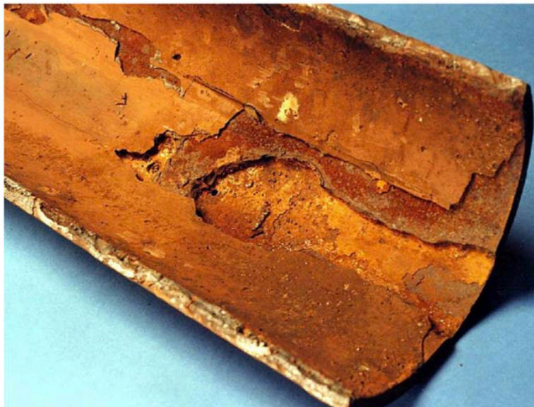
Figura 8 Corrosión por picaduras
