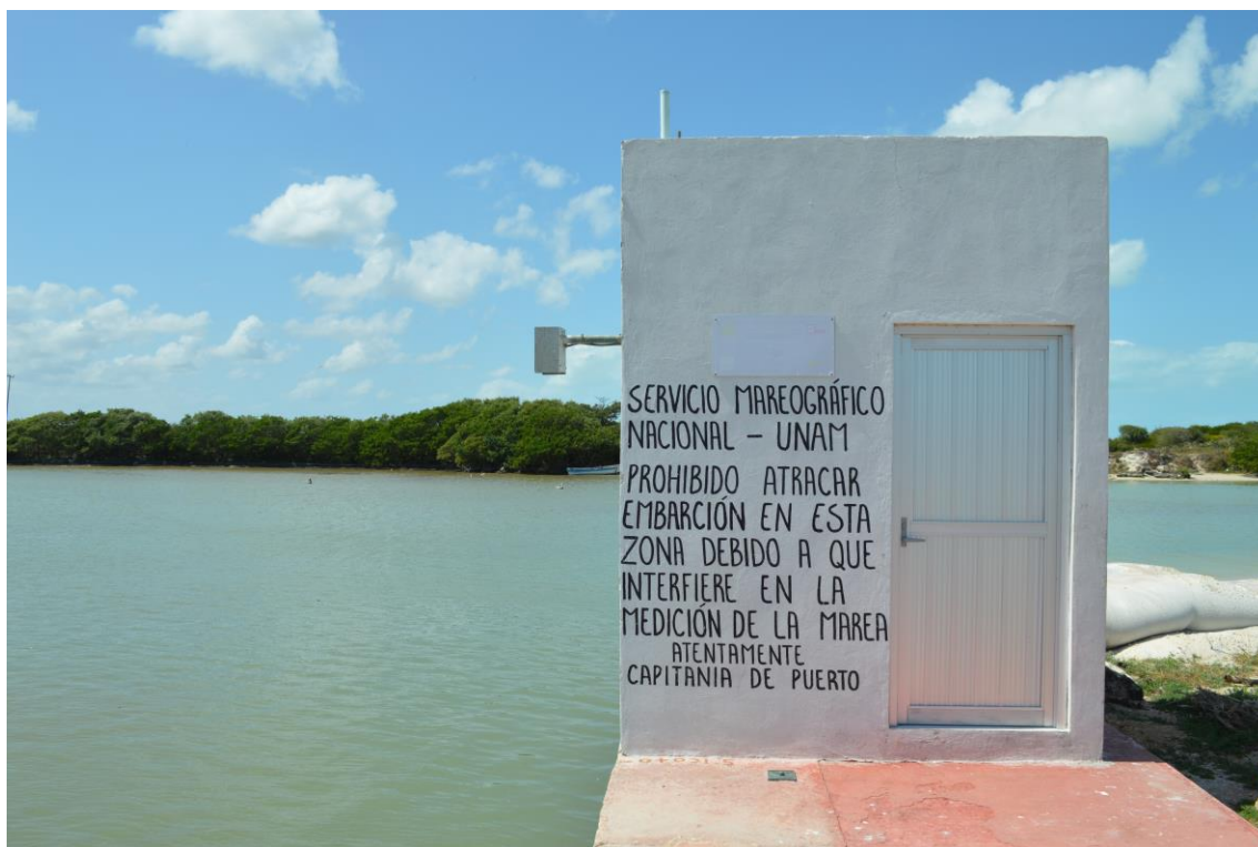
Figura 15. Estación mareográfica de la UNAM ubicado en el puerto de abrigo de Sisal.
