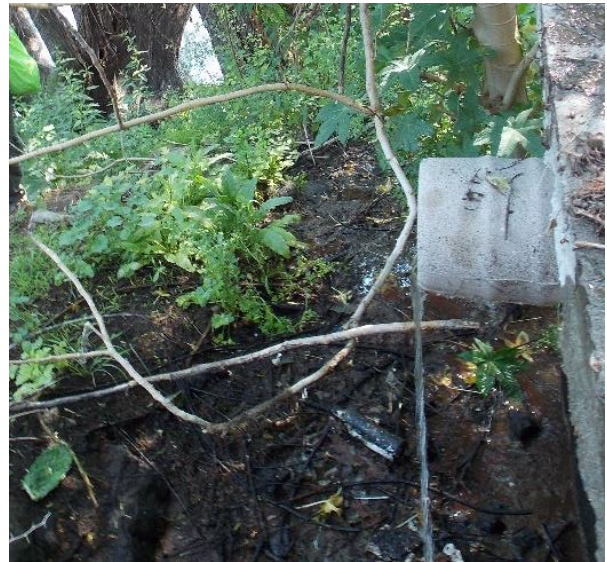
FIGURA 14 DESCARGA, PUNTO DE MUESTREO "POTABILIZADORA"
