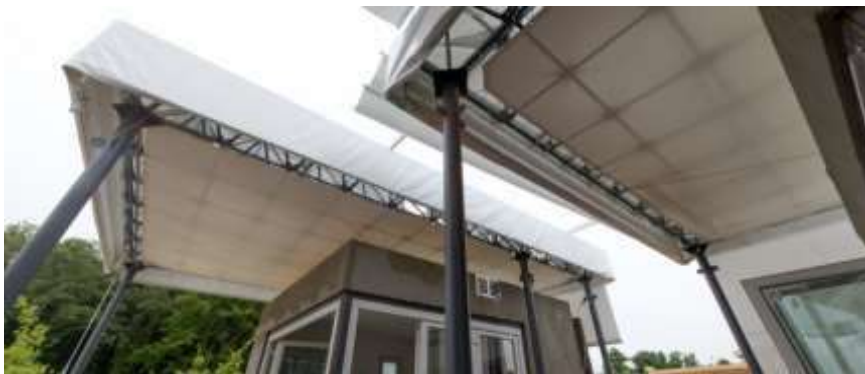
Fig. 28. Sistema de captación pluvial.
