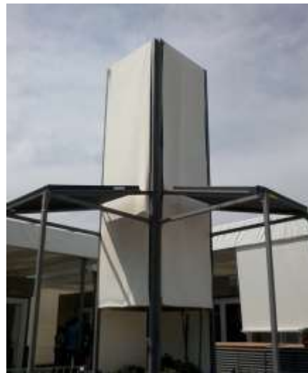
Fig. 31. Torre de agua y calentadores solares de agua.
