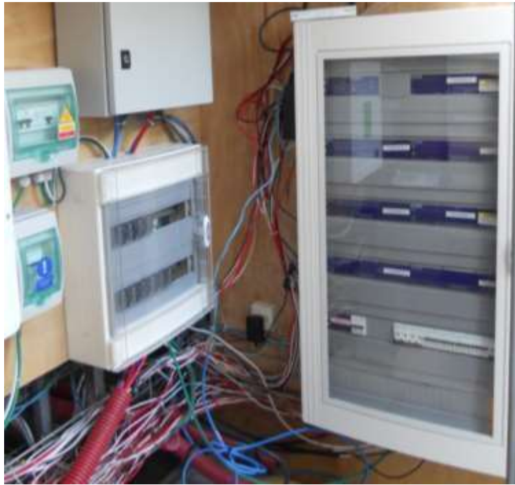
Fig. 117. Instalación del tablero de control de Clipsal (derecha).
