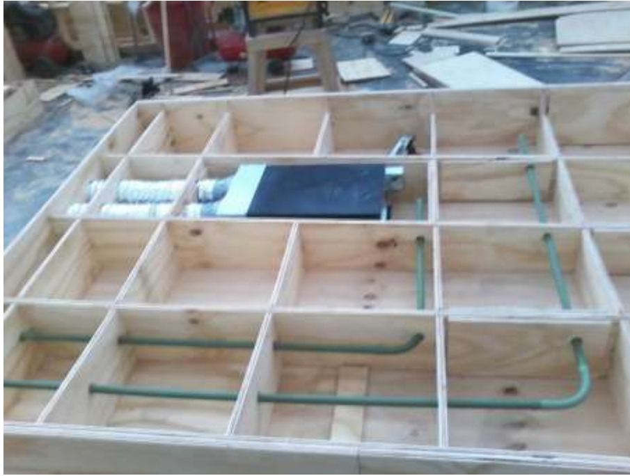
Fig. 115. Instalación de tubería en techo para sensores de presencia, iluminación y ERV.
