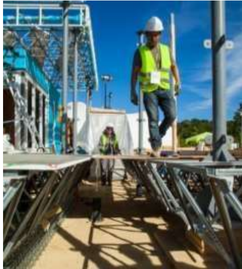
Fig. 24. Sistema estructural de piso y techo.
