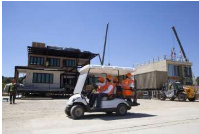
Fig. 2. Observadores y voluntarios durante la construcción en el decatlón solar 2014.
