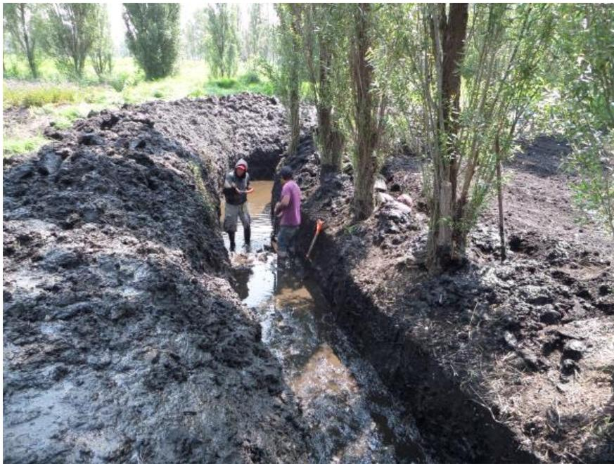
Imagen 4. Apertura y rehabilitación de apantles
