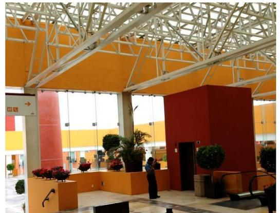
Columnas de acero soportan armaduras de acero.
