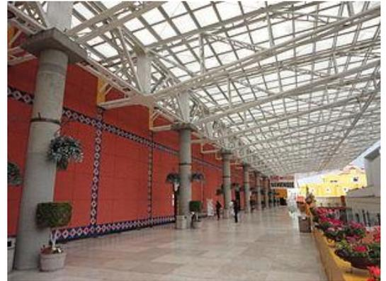
Columnas de concreto soportan armaduras de acero.
