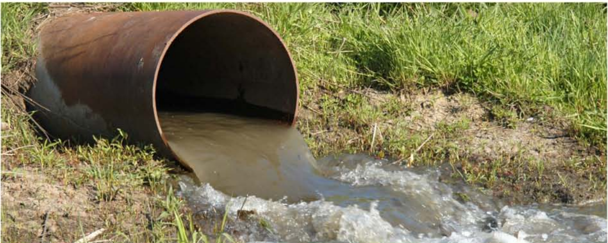
El agua contaminada es un factor de riesgo para el contagio de la hepatitis
