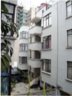
FOTOGRAFÍA ESTADO ACTUAL interior del edificio
