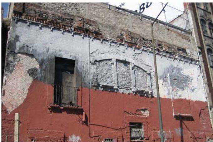
18. Fotografía de edificio en Callejón S. Ignacio.
